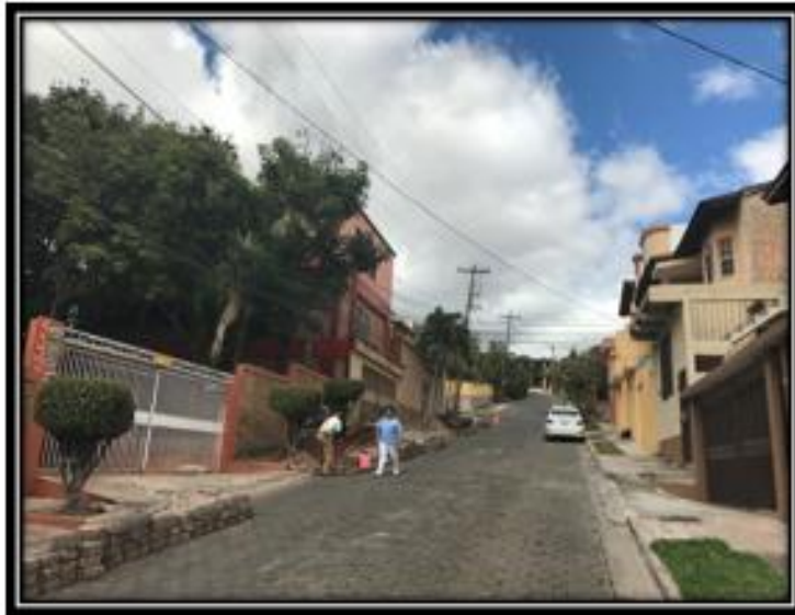
Foto No. 1: Inicio de calle a pavimentar
