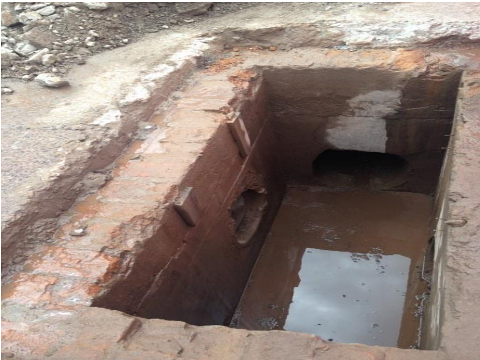
Reparación del tragante de aguas lluvias
