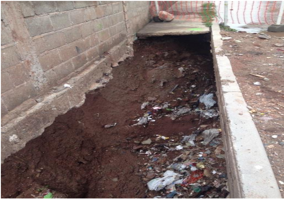
Reparación de aproximación del puente
