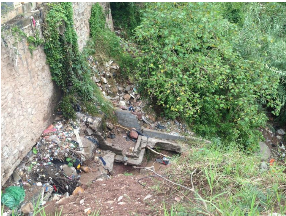
Vista panorámica del tragante de aguas lluvias
