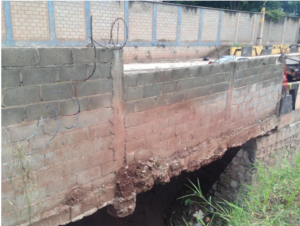
Construcción de muro
