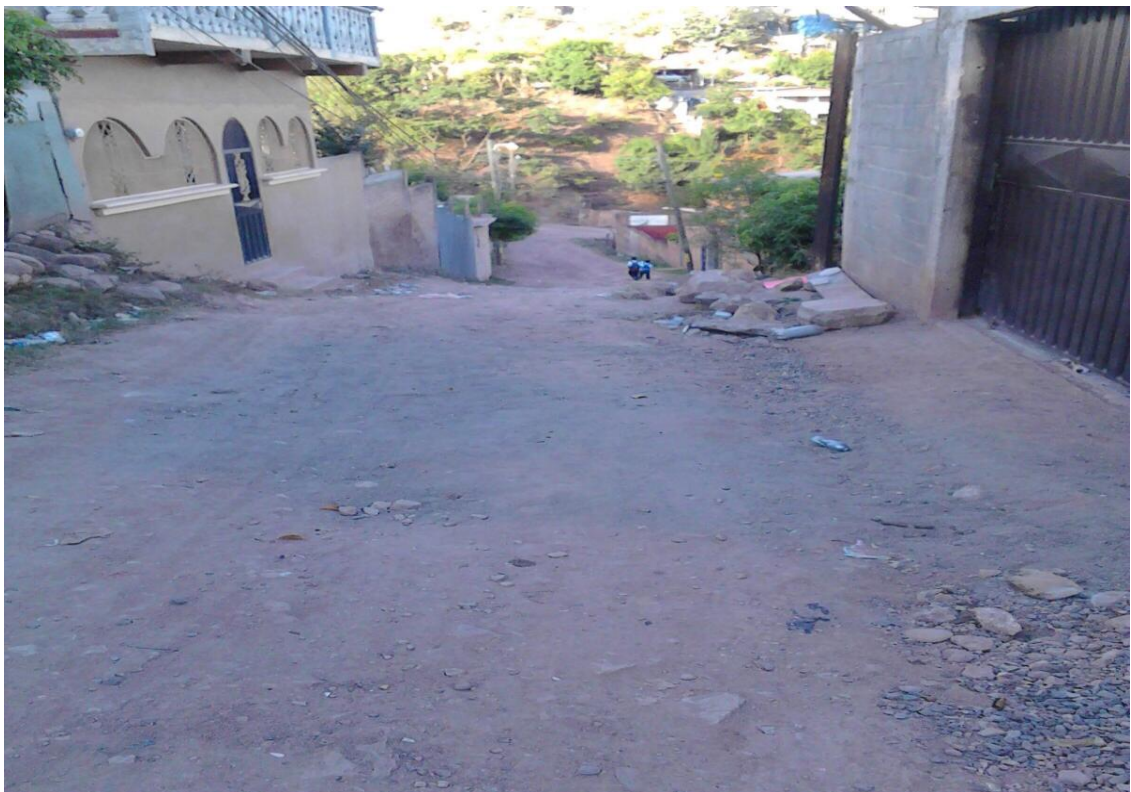
FINAL DE CALLE A PAVIMENTAR
