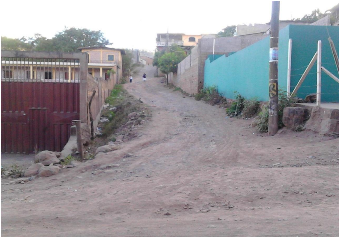
UBICACIÓN DE MURO DE CONTENCION
