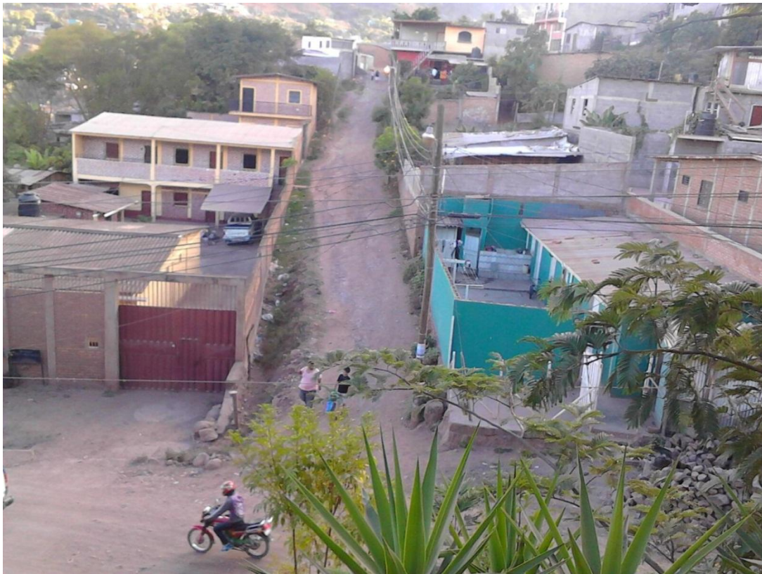
INICIO DE PAVIMENTACION DE CALLE
