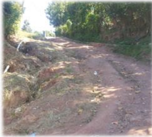
VISTA DE DONDE SE CONSTRUIRÁN LAS CUNETAS
