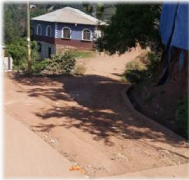
INICIO DE CALLE DONDE SE CONSTRUIRÁN LAS HUELLAS VEHICULARES
