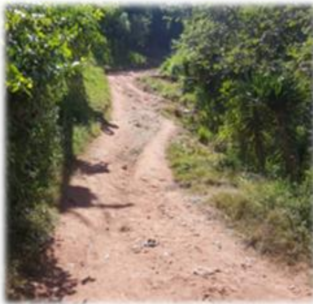
VISTA DE CALLE DONDE SE CONSTRUIRÁN LAS HUELLAS VEHICULARES
