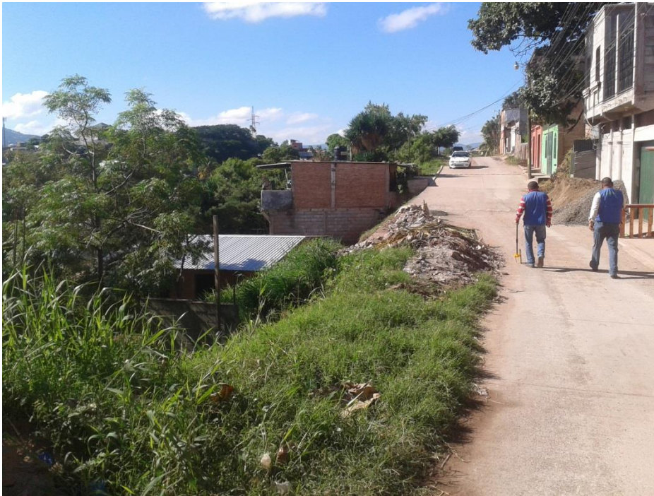
Vista tramo concreto hidráulico y construcción de muro
