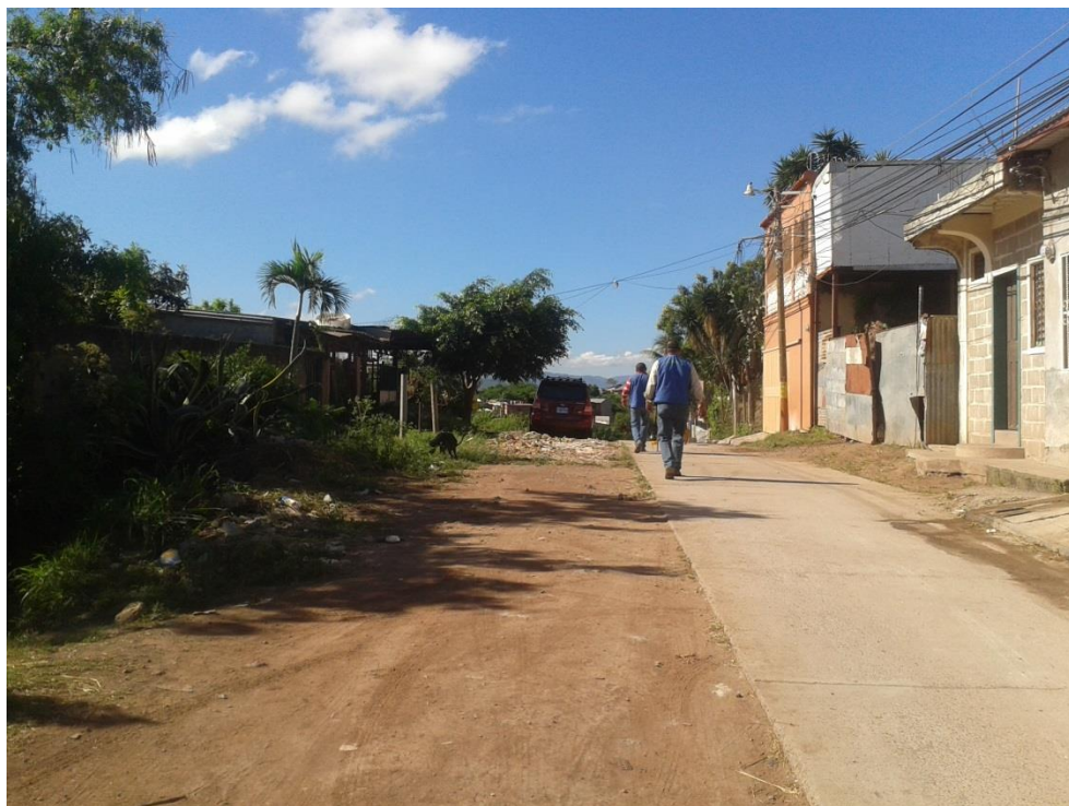
Vista de tramo a pavimentar concreto hidráulico
