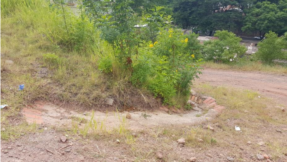
Vista panorámica de ubicación de cunetas
