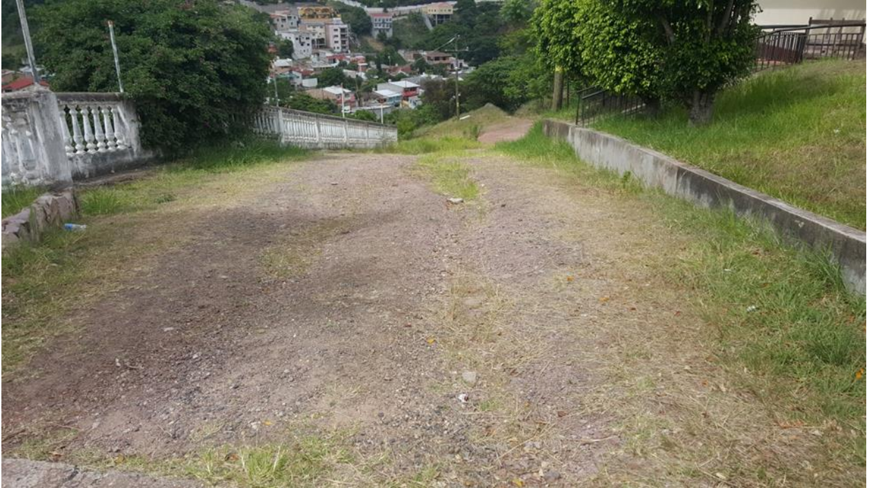
Inicio de proyecto de pavimentación.
