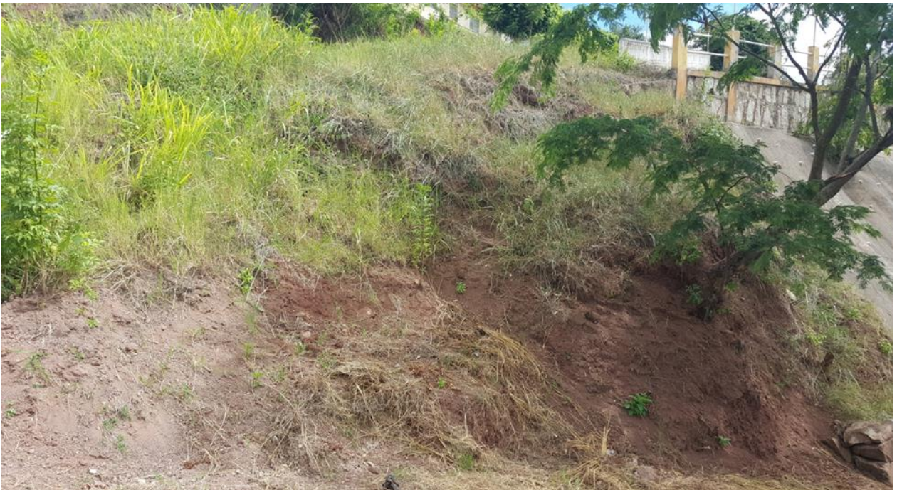
Ubicación de muro de contención
