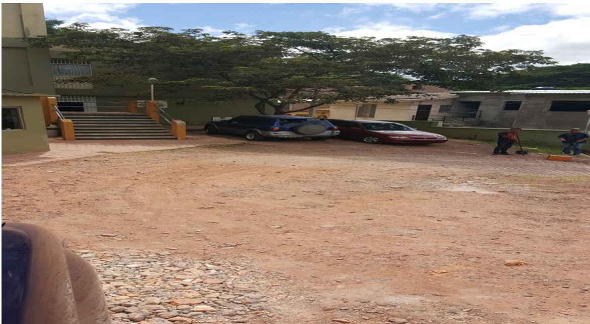
Final de proyecto de pavimentación
