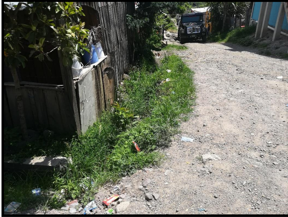
No.3 Inicio de ramal secundario de cunetas
