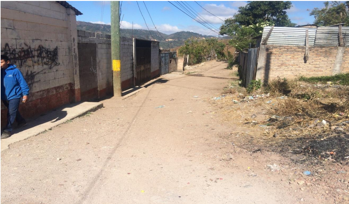
Inicio de la calle a pavimentar
