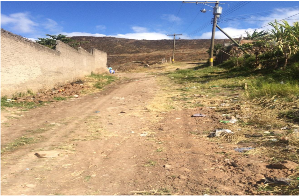
Vista de una sección de la calle a pavimentar
