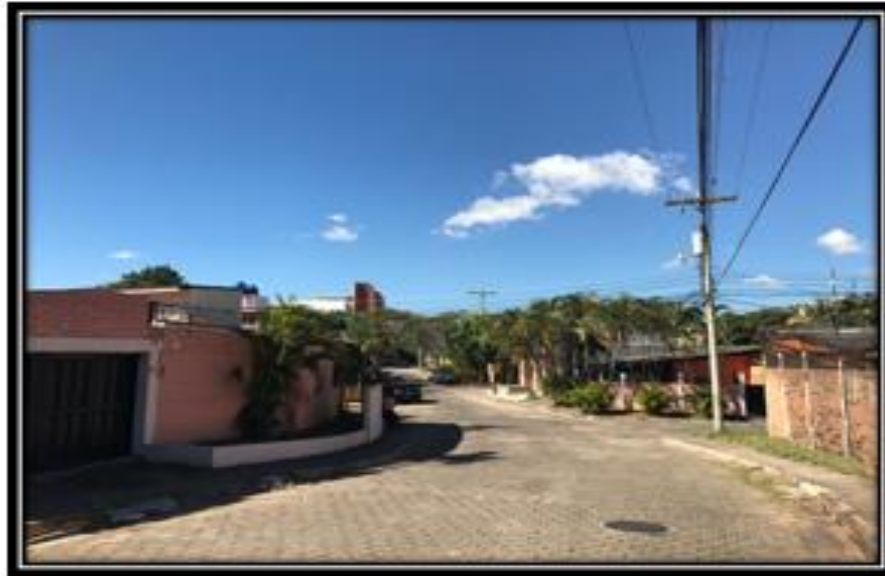
Foto No. 1: Inicio de calle a pavimentar
