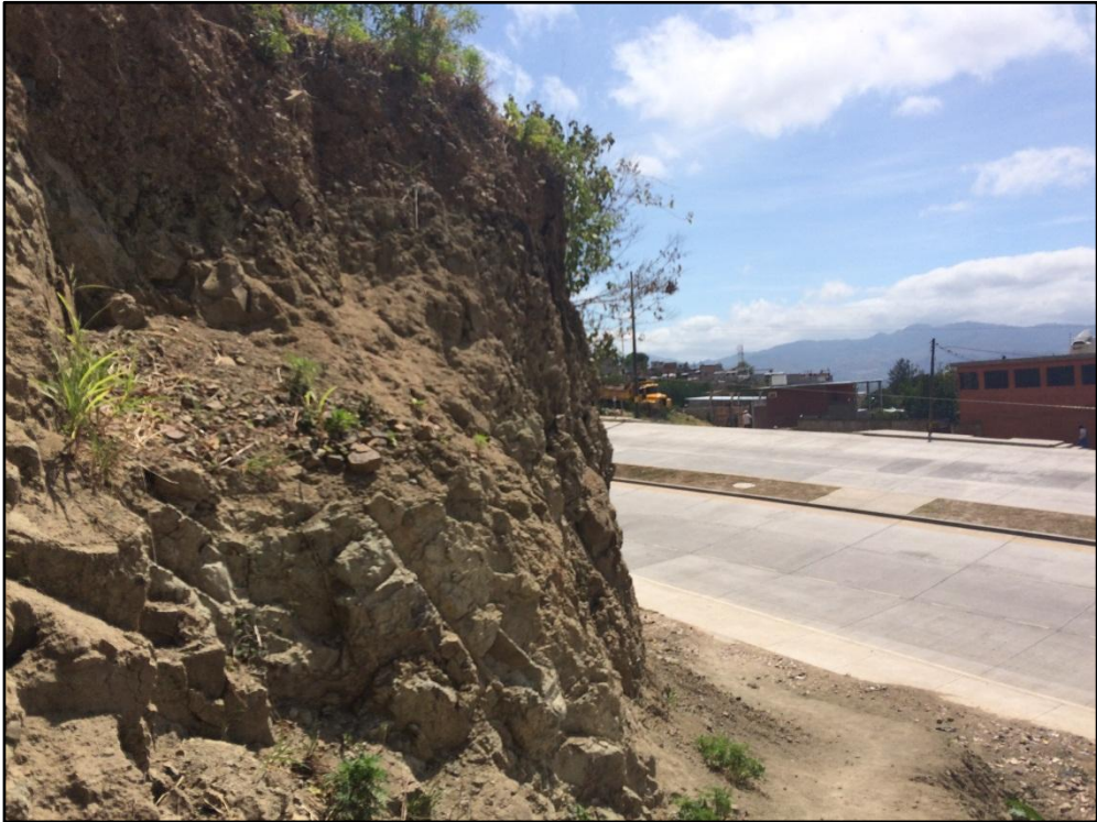
Foto 6. Talud a estabilizar
