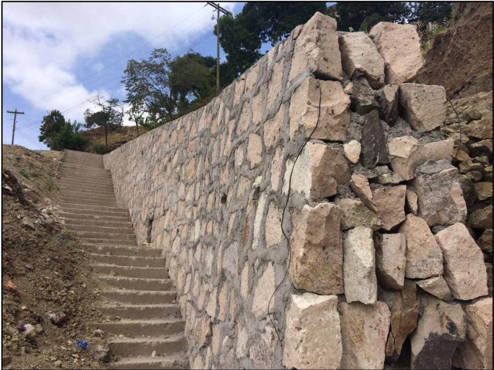
Foto 4. Construcción de muro de contención y gradas
