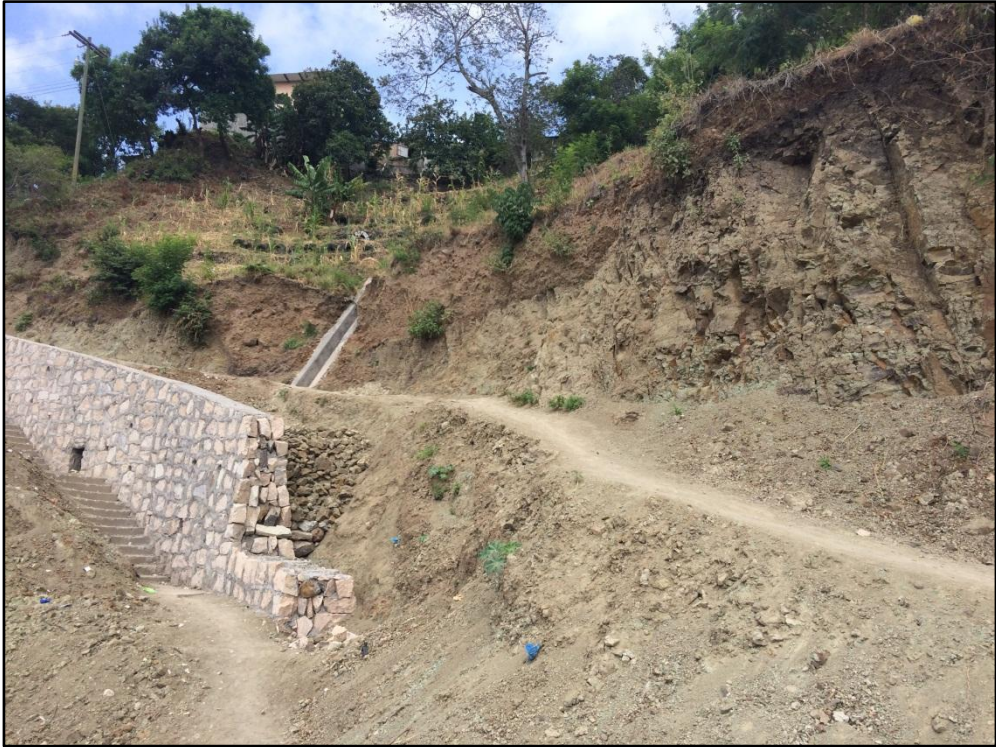
Foto 3. Construcción de muro de contención
