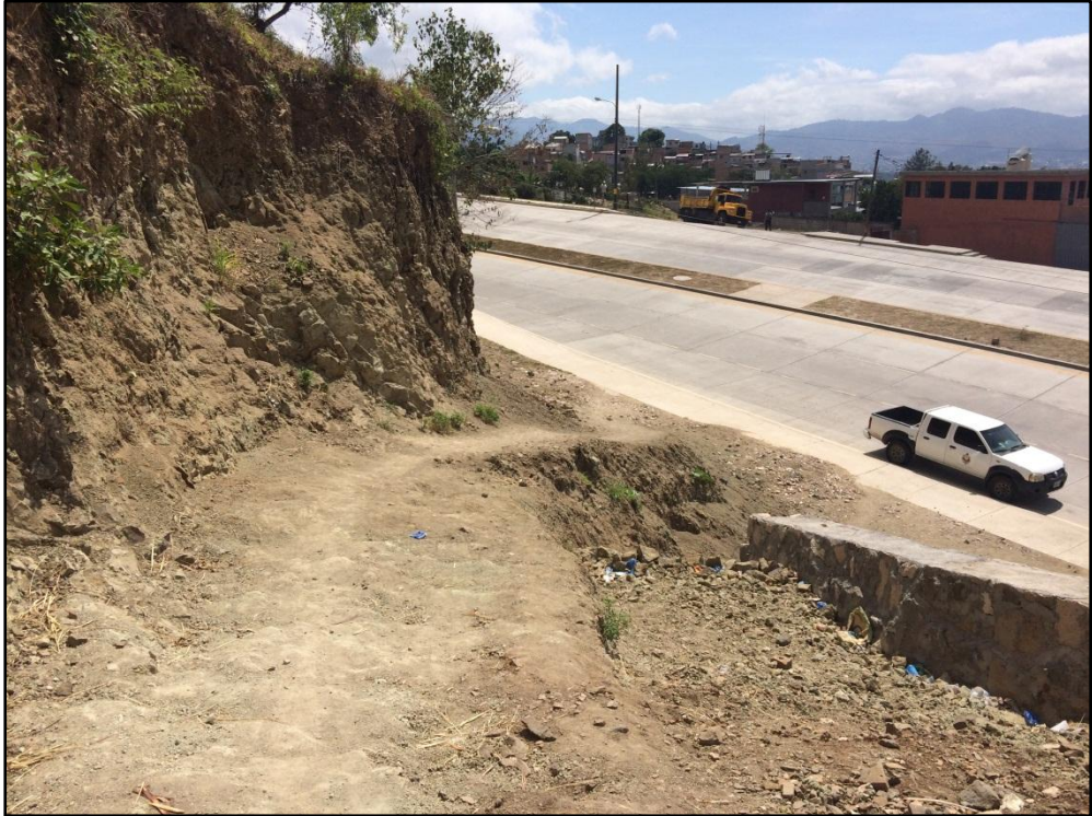
Foto 2. Vista acceso vehicular Colonia Altos de Centroamérica, donde se ubica el inicio del tramo a pavimentar
