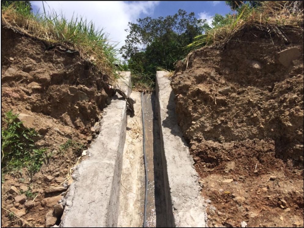
Foto 5. Construcción de drenaje de aguas lluvias
