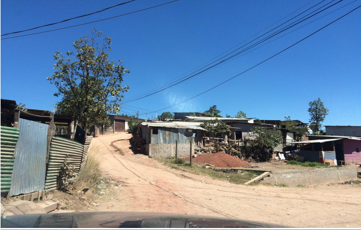
VISTA DEL INICIO DEL TRAMO A REPARAR
