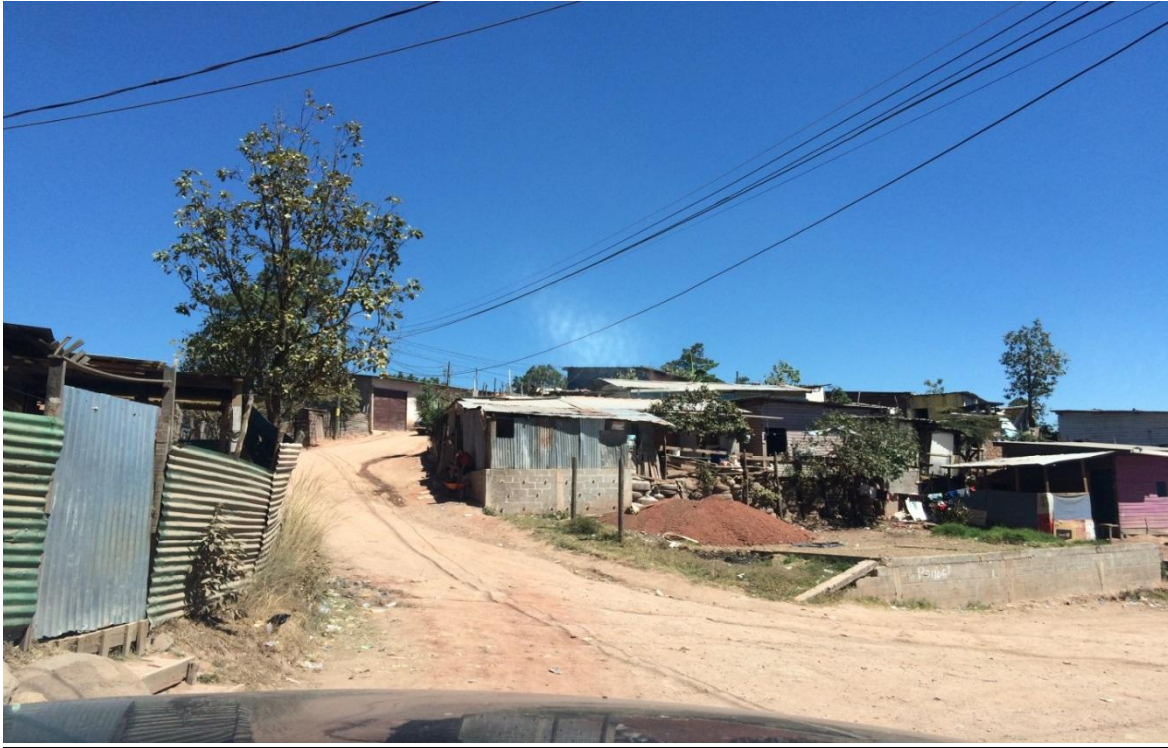
VISTA DEL INICIO DEL TRAMO A REPARAR
