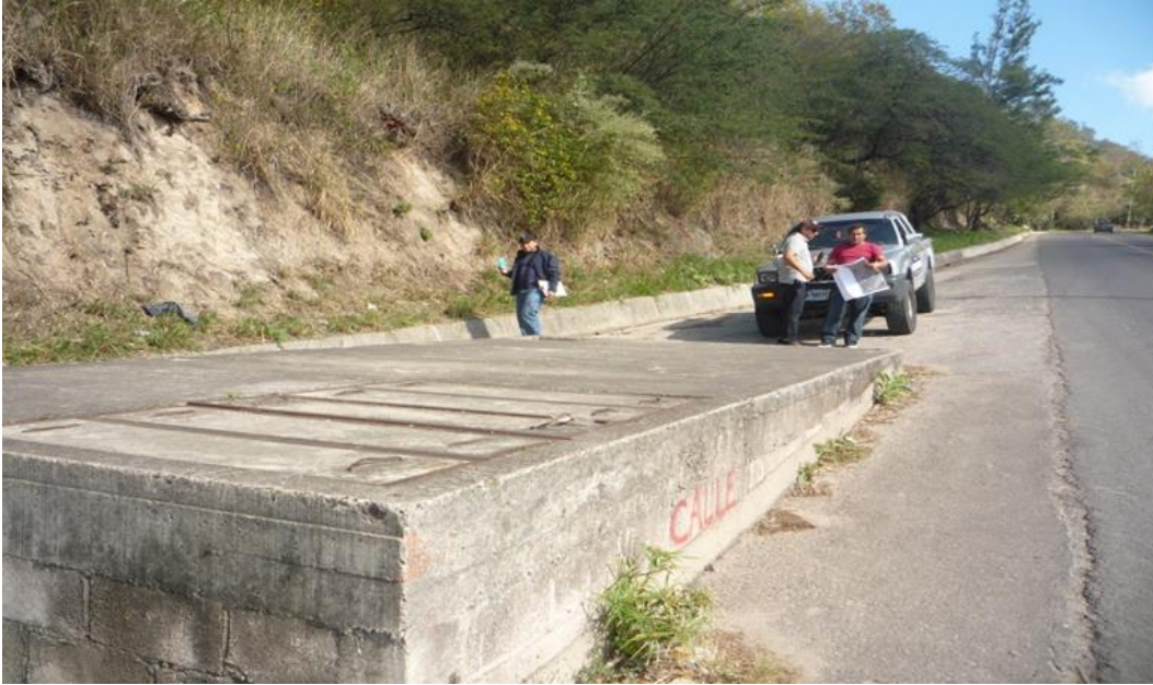
INICIO DE PROYECTO EN QUE SE MEJORARÁN LAS TUBERÍAS DEL SISTEMA DE AGUA POTABLE
