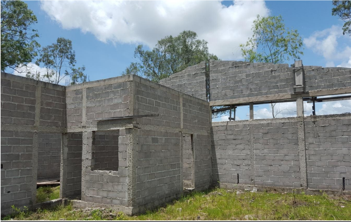
VISTA DE LA OBRA EN ESTADO GRIS
