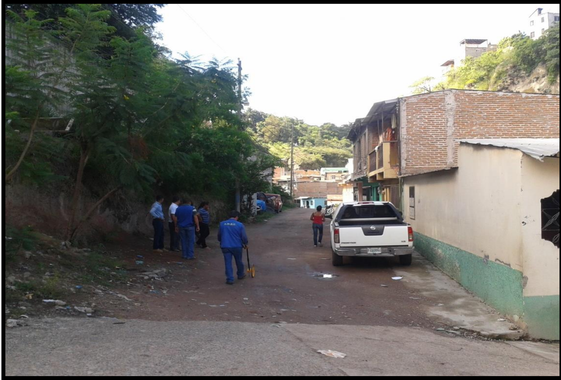
Inicio de pavimentacion de calle
