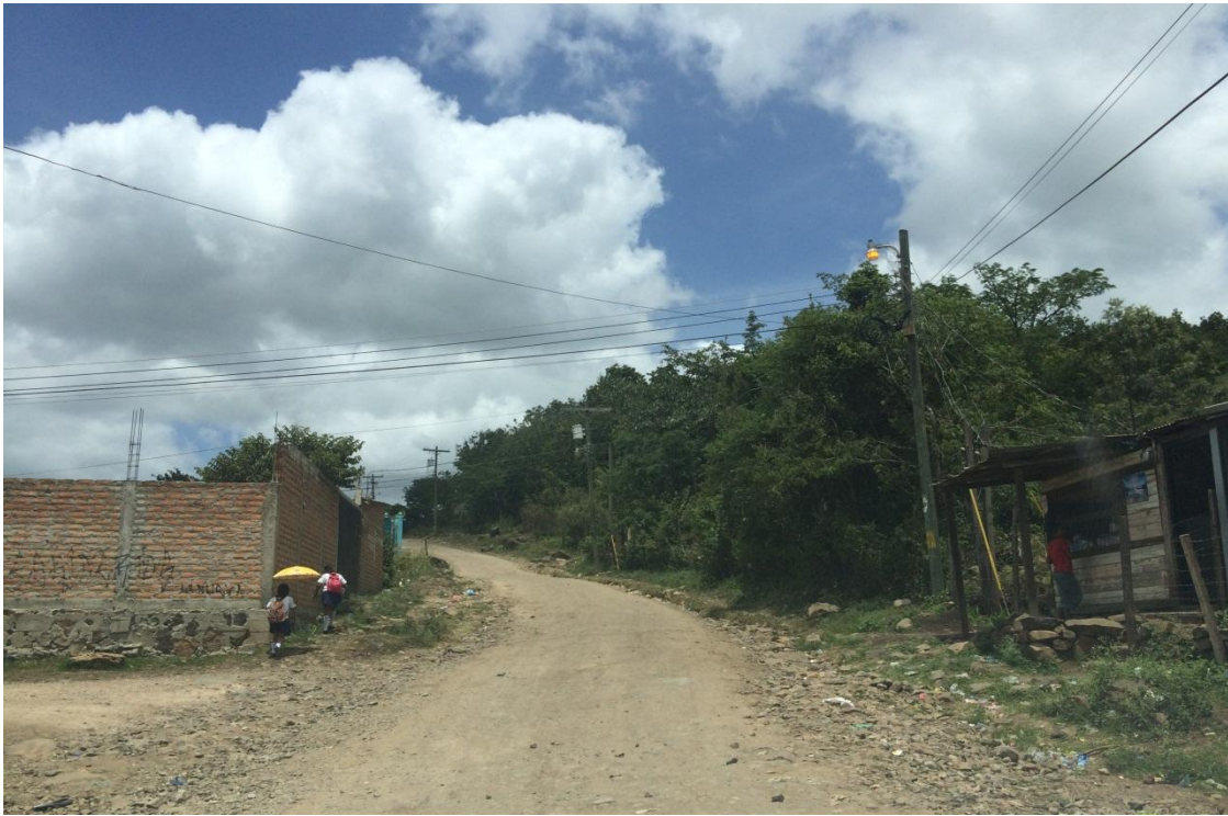
VISTA DEL TRAMO FINAL DE LA REPARACION
