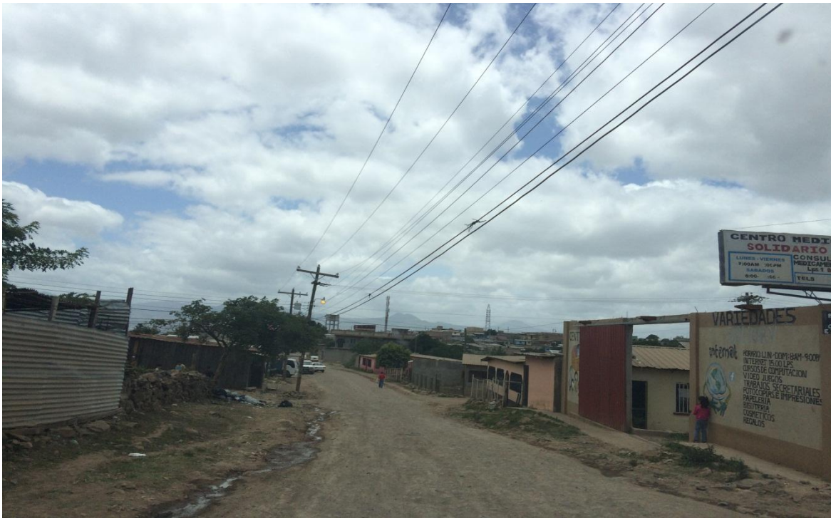
VISTA PANORAMICA DEL TRAMO, COL. NUEVA AUSTRALIA
