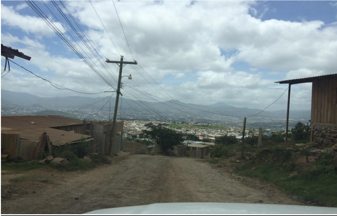
VISTA DEL TRAMO DONDE SE CONSTRUIRAN LAS HUELLAS
