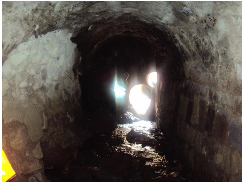
Vista dentro del embaulado existente
