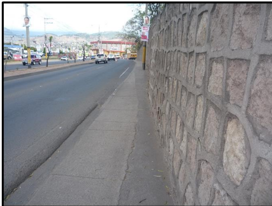
PANORAMA EN DONDE SE EJECUTARÁ LA OBRA
