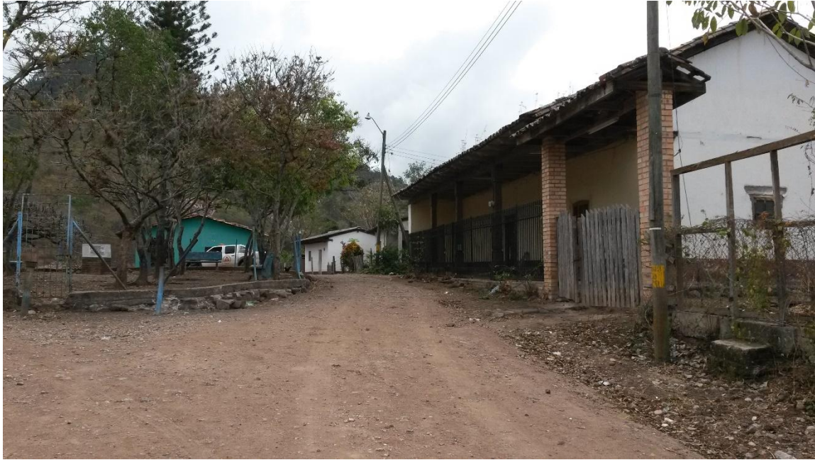
VISTA PANORÁMICA DEL TRAMO ENTRE EL PARQUE Y SALÓN COMUNAL QUE SE VA A PAVIMENTAR
