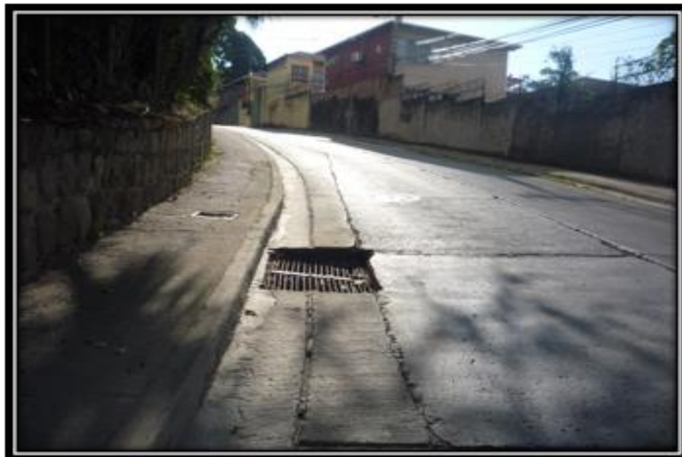
Foto No. 2: Final Col. El Porvenir
