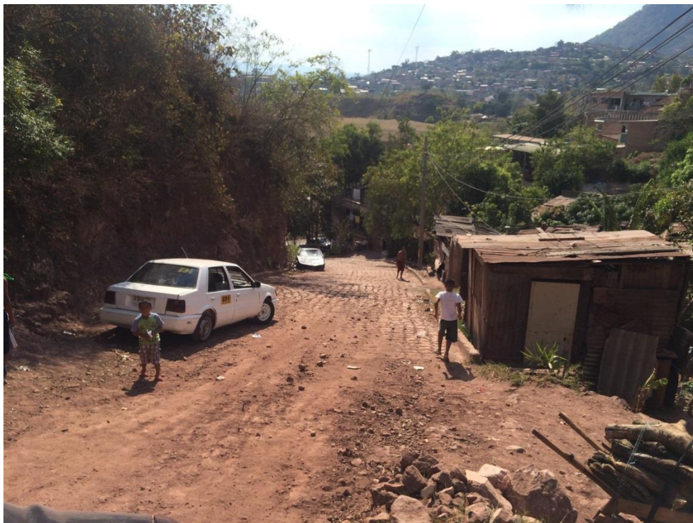
Fin de la calle donde se construira huellas
