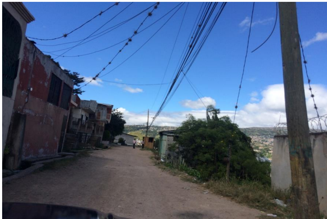
Vista de calle a pavimentar con concreto hidraulico
