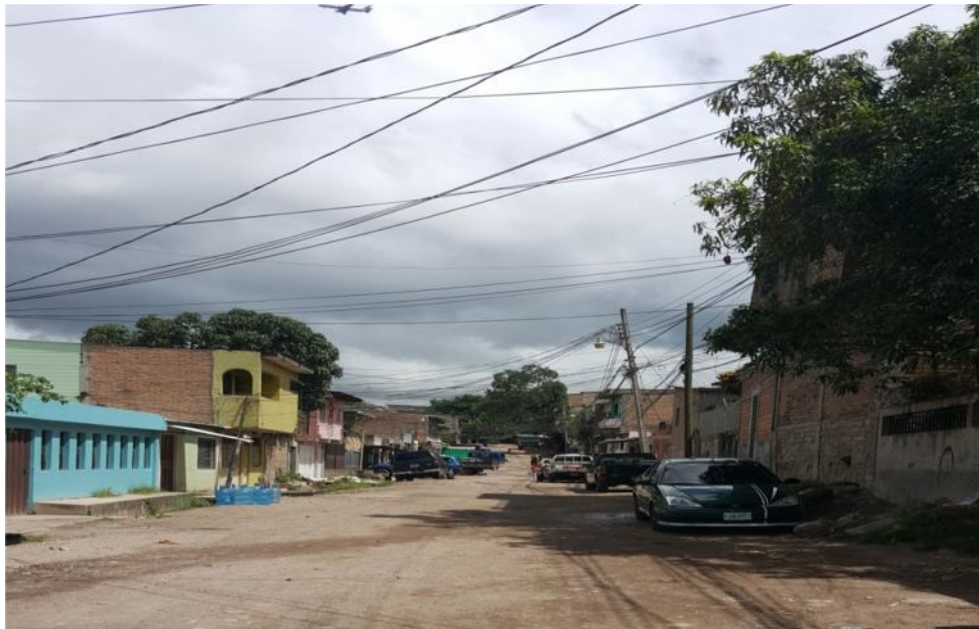
Vista panorámica de Tramo a Pavimentar
