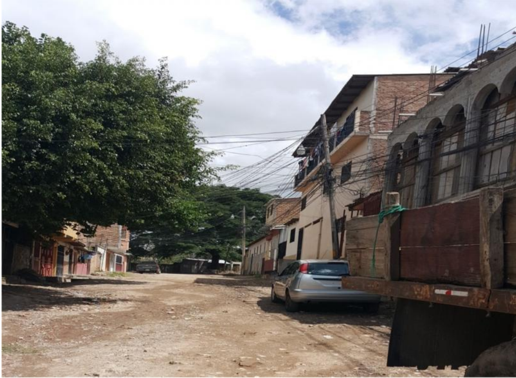
Vista panorámica de Tramo a Pavimentar
