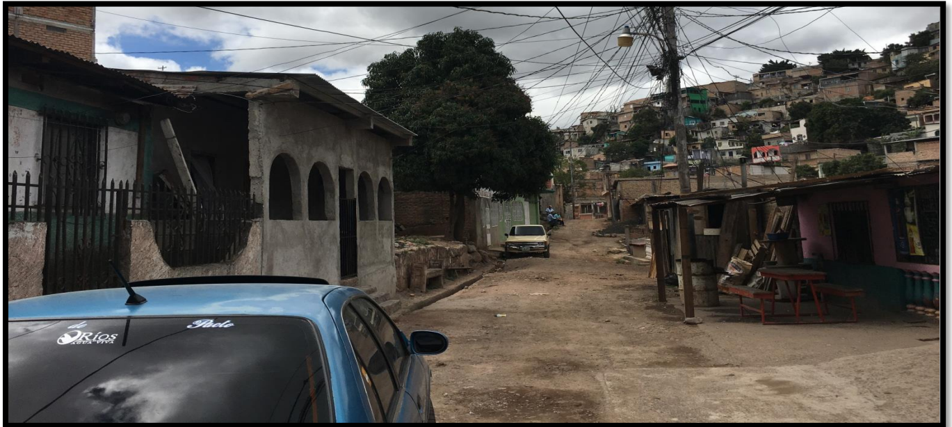
VISTA DEL INICIO DEL TRAMO A PAVIMENTAR
