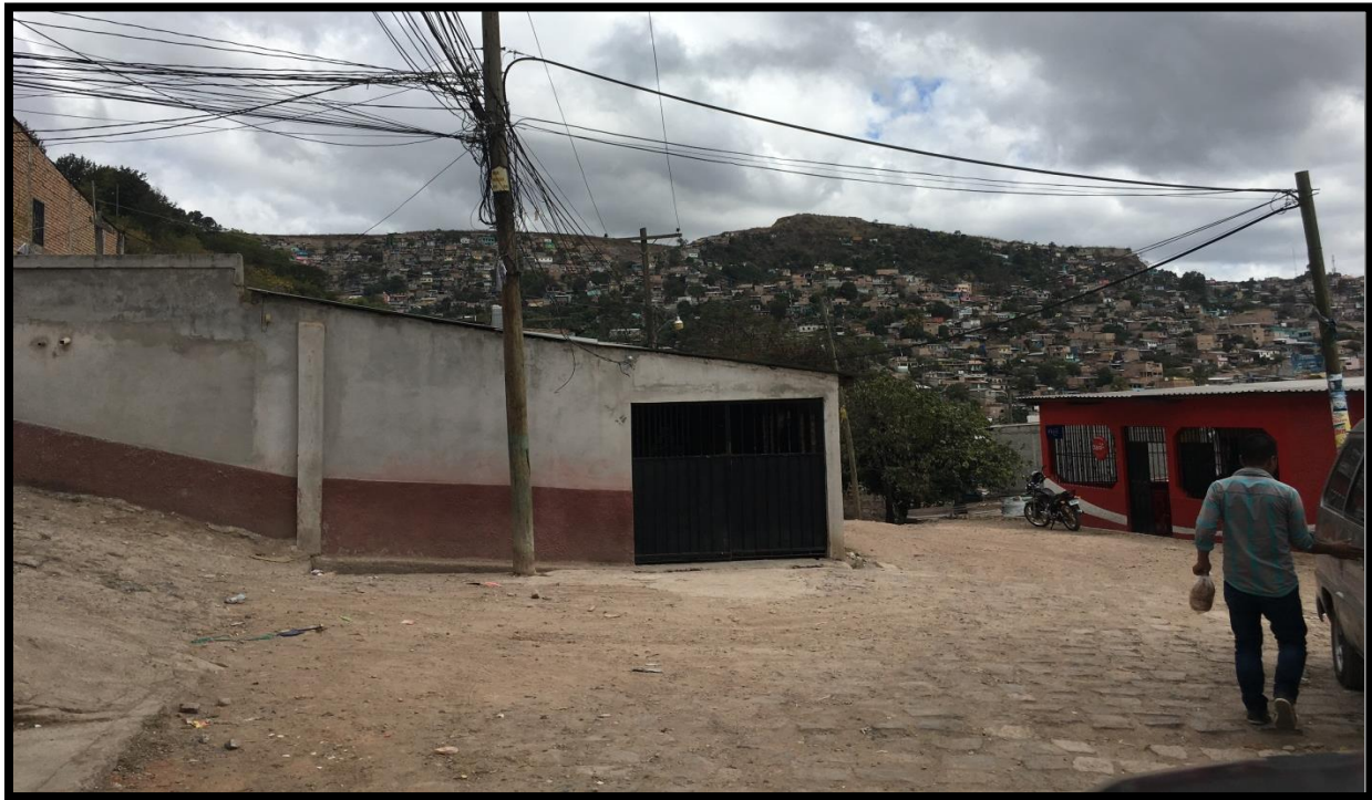
CALLE A PAVIMENTAR CON CONCRETO HIDRÁULICO
