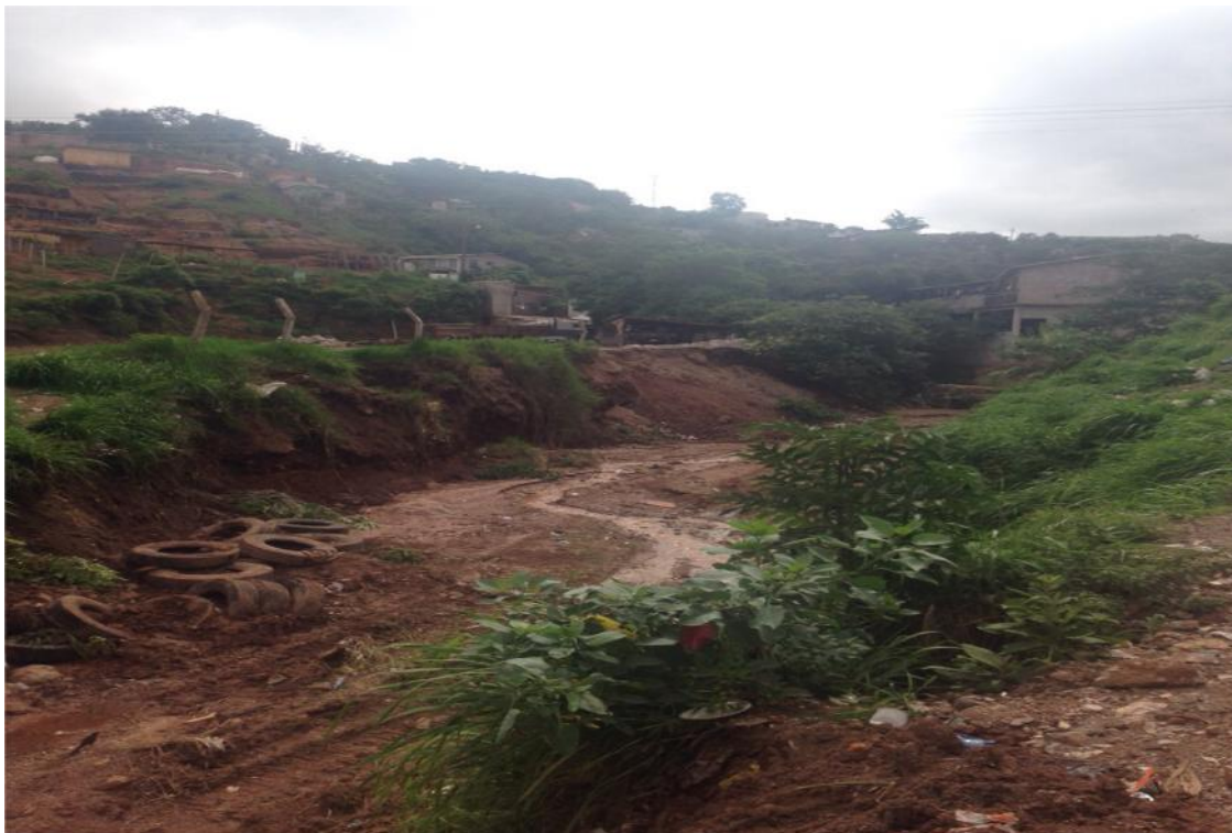
CAUCE DE LA QUEBRADA A DESVIAR
