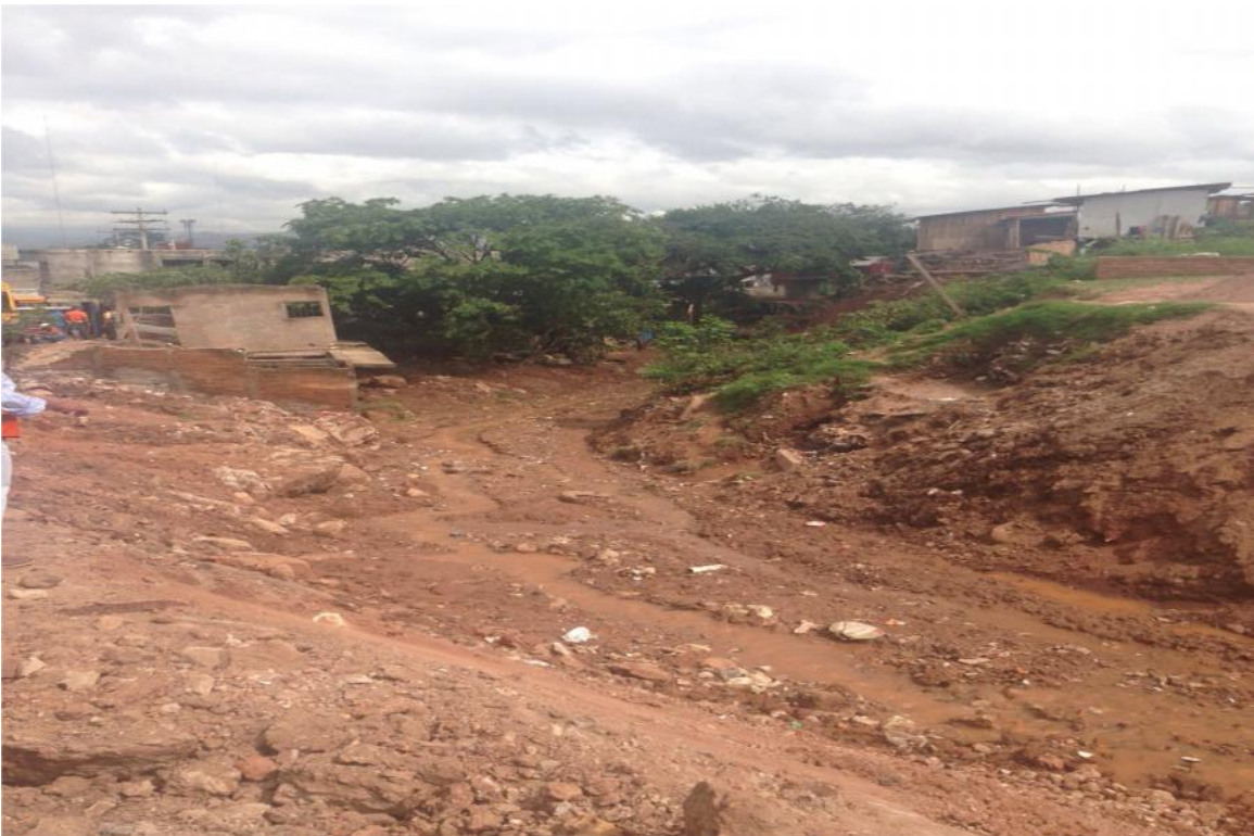
VISTA PANORAMICA DE LA CONSTRUCCION DE LA CAJA PUENTE
