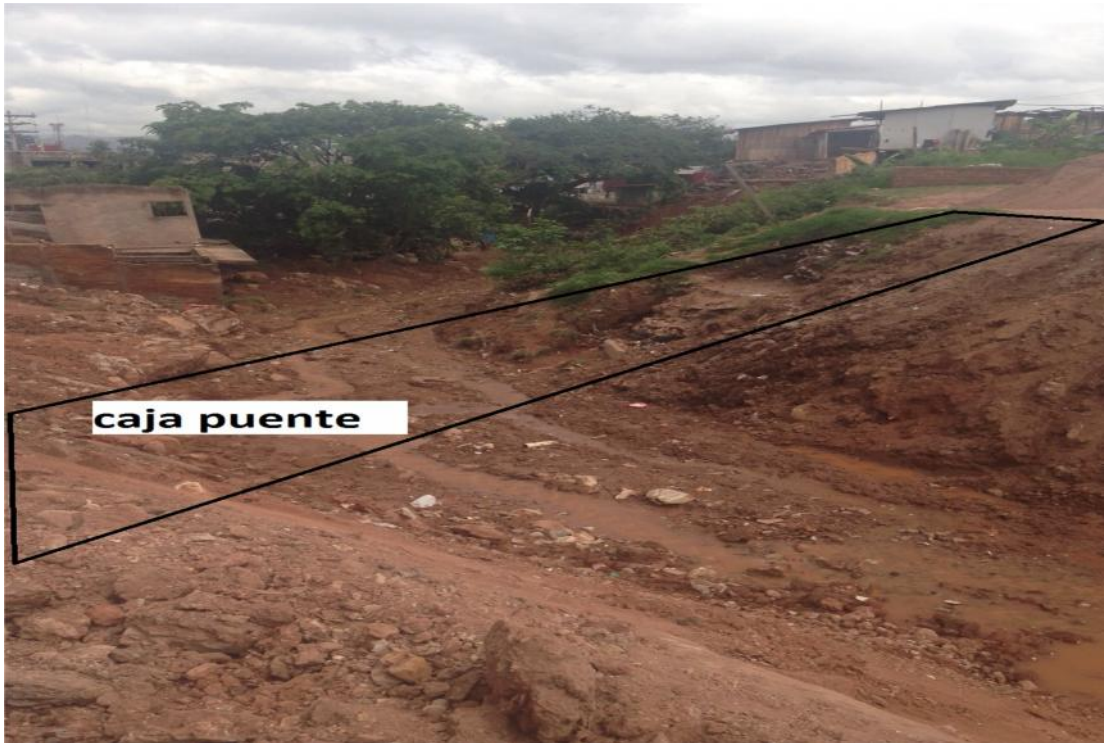
CONSTRUCCION DE CAJA PUENTE
