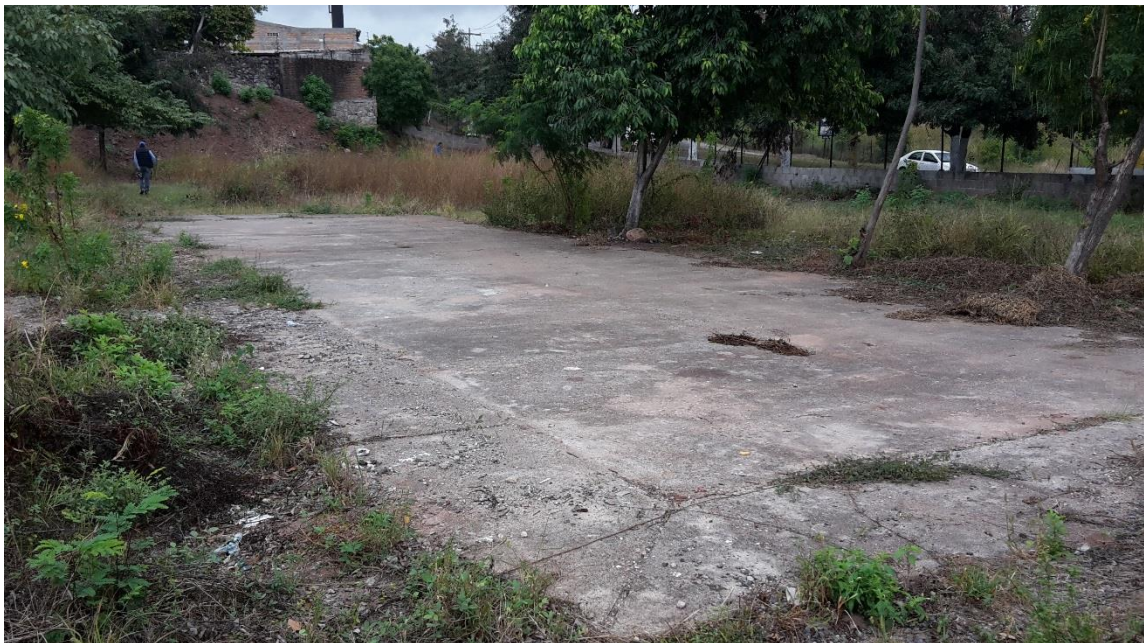
FIRME DE CONCRETO A DEMOLER
