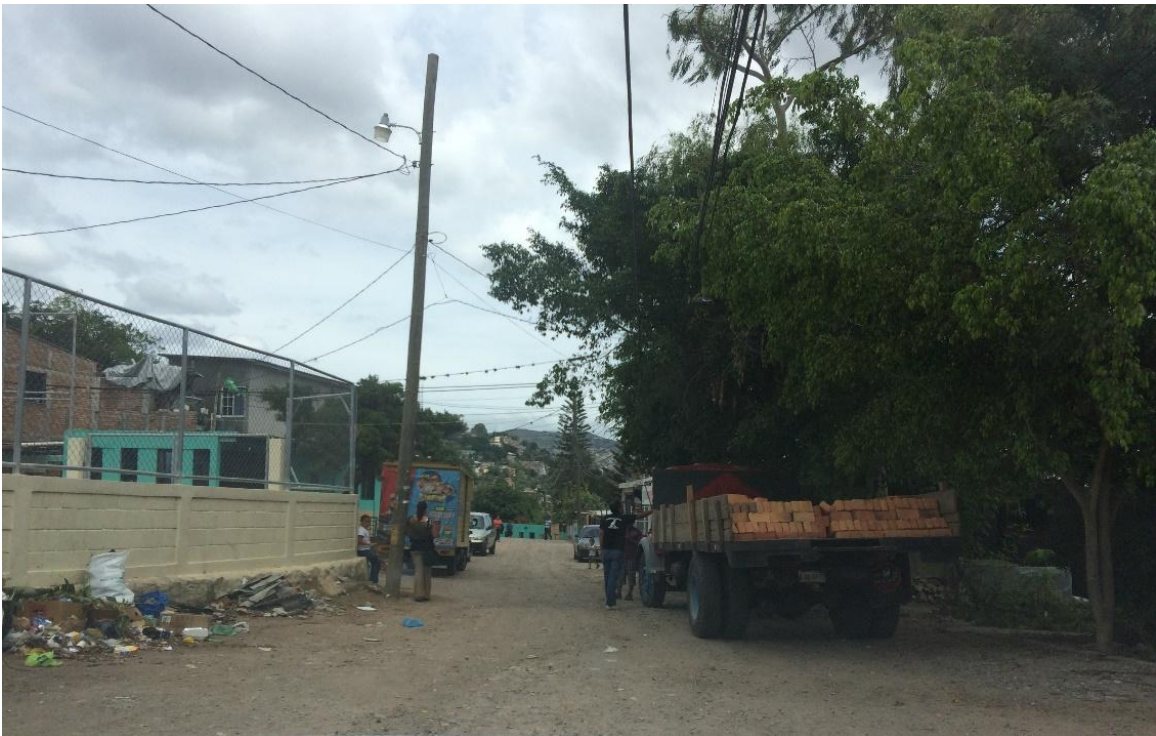
Vista panorámica del tramo a pavimentar
