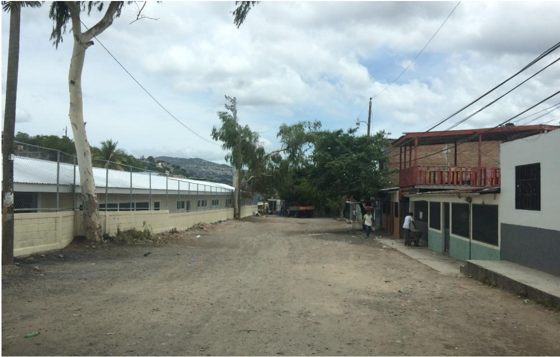
Vista panorámica del inicio del proyecto
