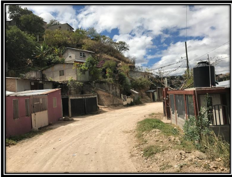
Foto No. 3: Vista del estado actual de la calle
