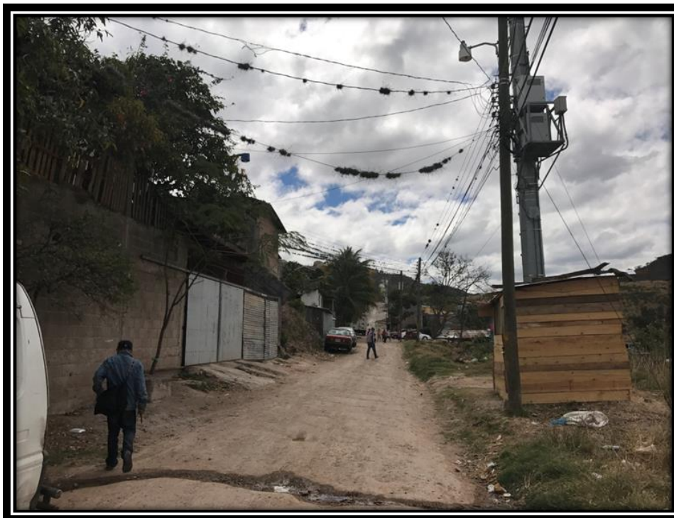
Foto No. 4: Final de la calle a pavimentar
