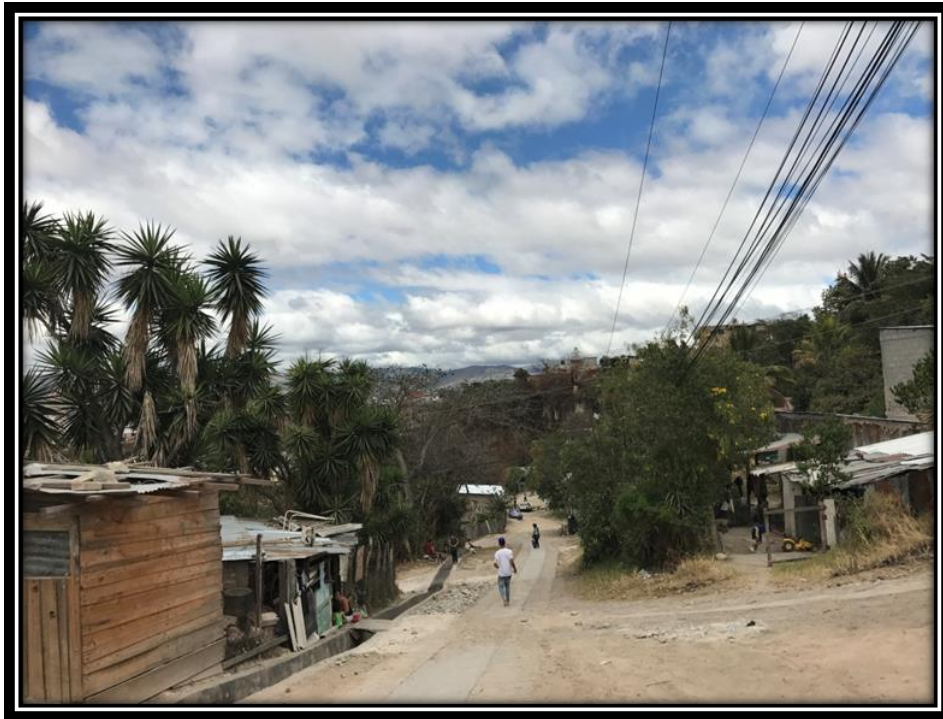
Foto No. 1: Inicio de calle a pavimentar
