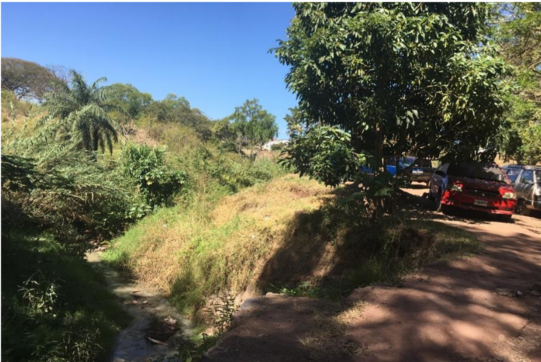
VISTA DONDE SE CONSTRUIRA EL MURO DE CONTENCIÓN
