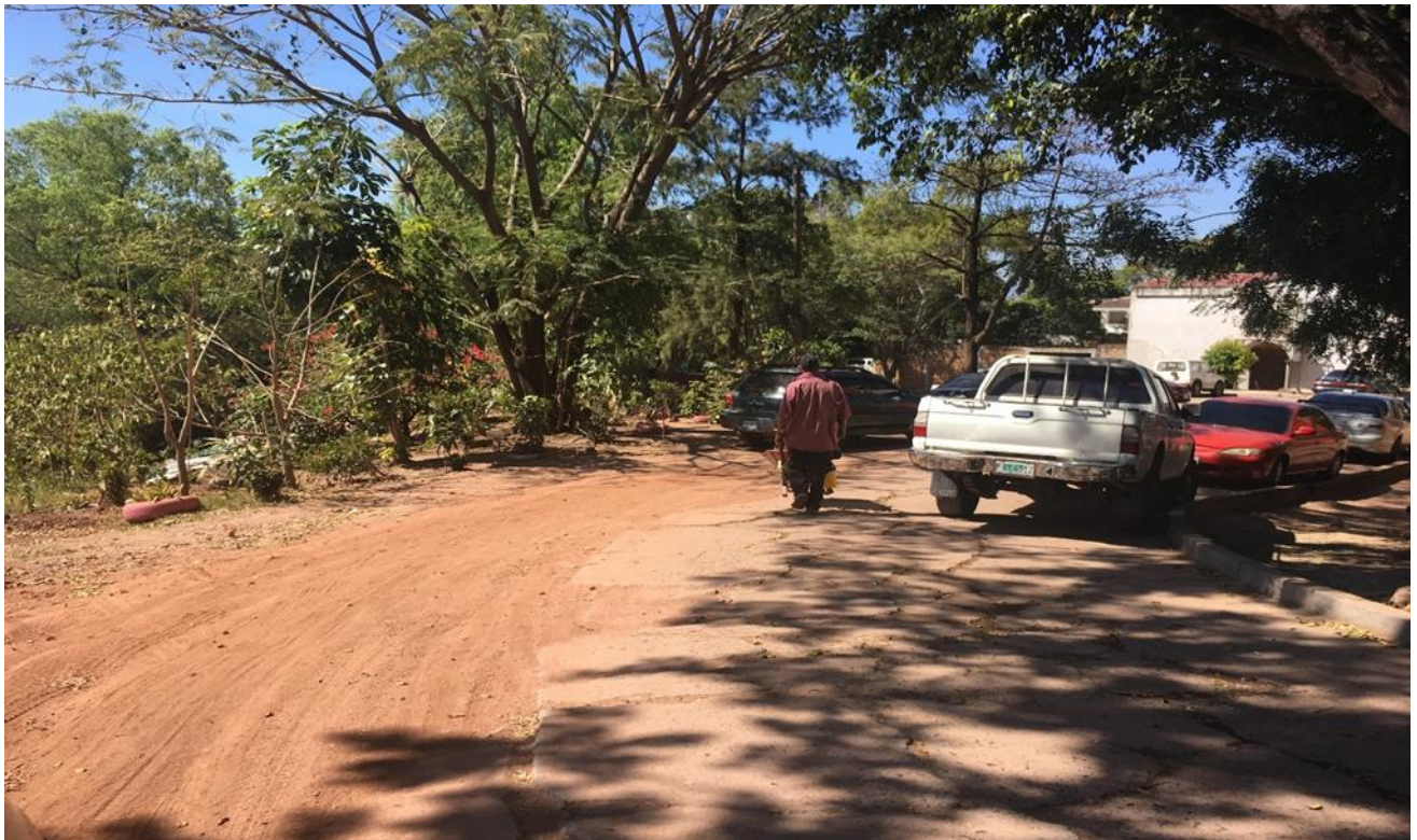
VISTA DE CALLE A PAVIMENTAR CON CONCRETO HIDRAULICO
