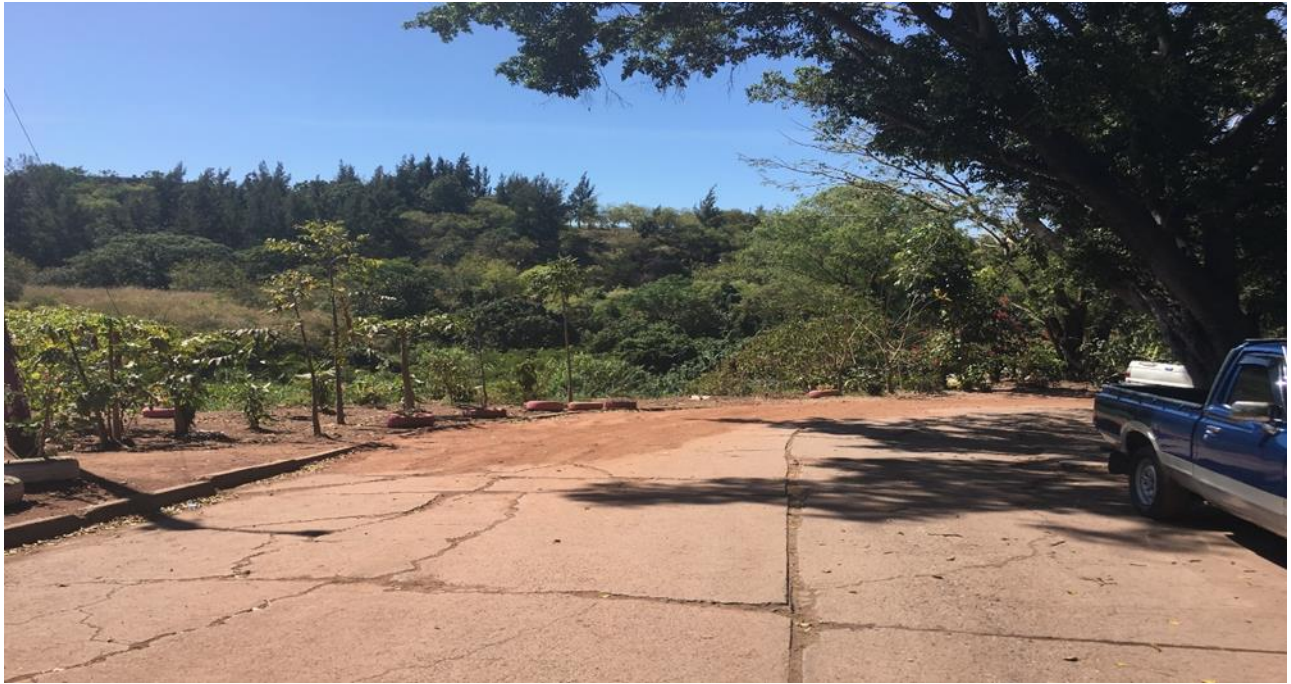
CALLE DONDE SE HARA LA DEMOLICION DE ELEMENTOS DE CONCRETO Y LUEGO LA PAVIMENTACION
