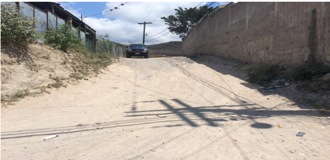
Fin de calle a pavimentar
