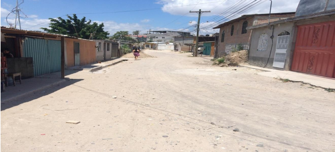
Vista de una seccion de la calle a pavimentar
