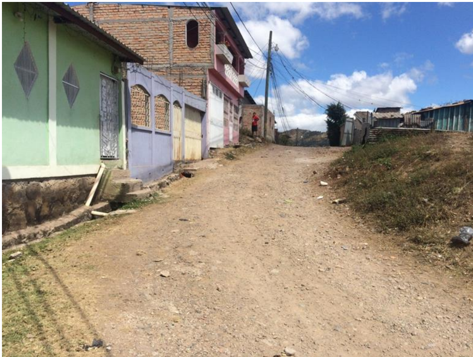
PANORAMA DE LA CALLE A PAVIMENTAR
