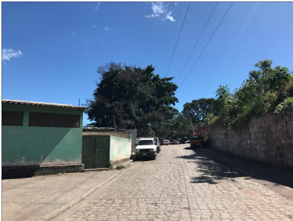
Vista de empedrado de calle a pavimentar con white topping
