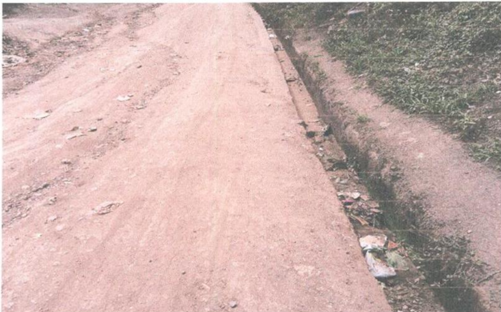
VISTA DE CALLE A PAVIMENTAR
