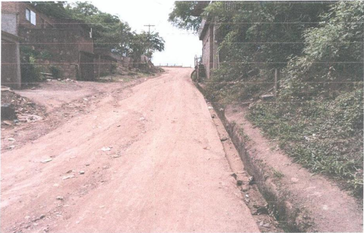
CONTINUACION DE CALLE A PAVIMENTAR
