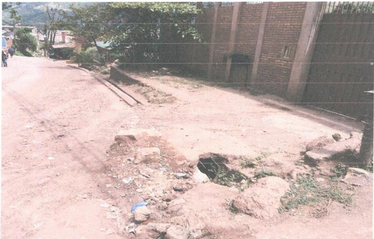
FINAL DEL PAVIMENTO
