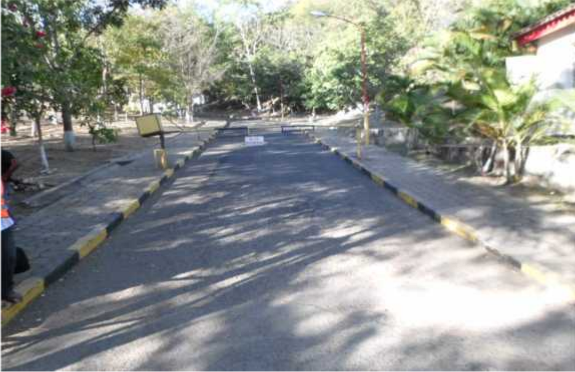
VISTA PANORAMICA DE CALLE A REHABILITAR
