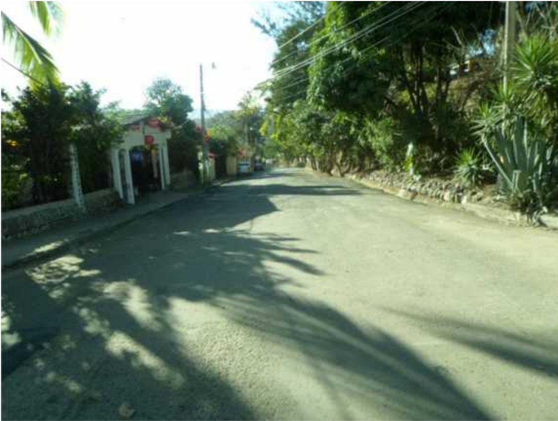
INICIO DE BACHEO Y REHABILITACION DE CALLE
