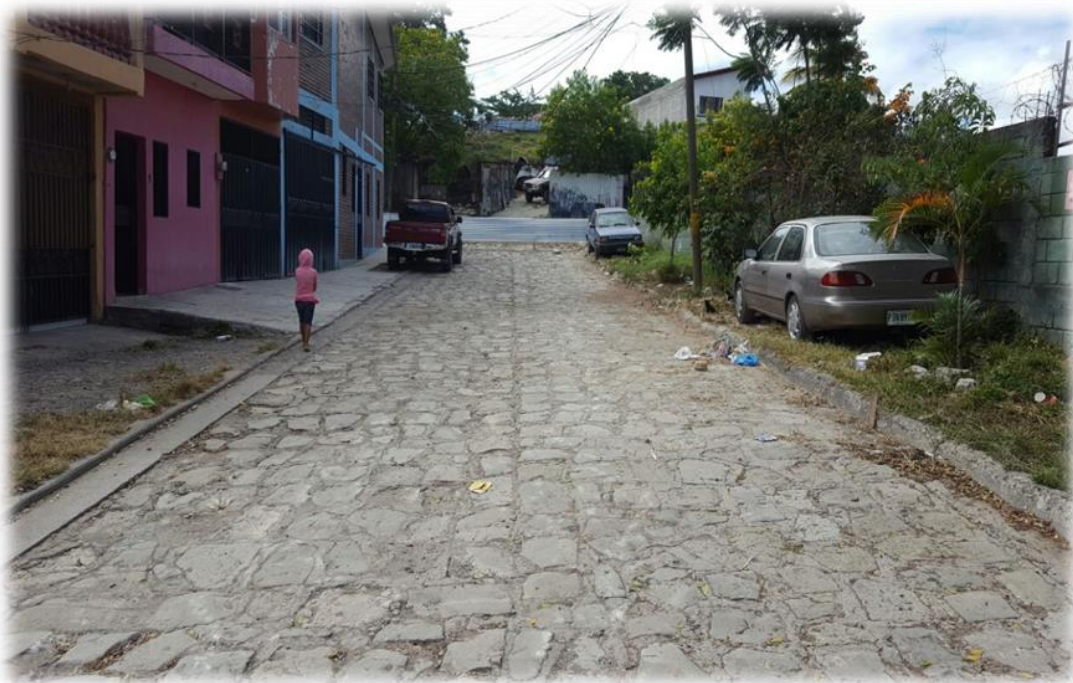
Vista de calle a pavimentar con white topping
