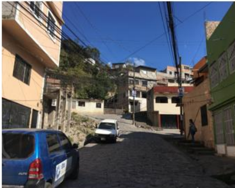
VISTA DE EMPEDRADO DE CALLE A PAVIMENTAR CON WHITE TOPPING
