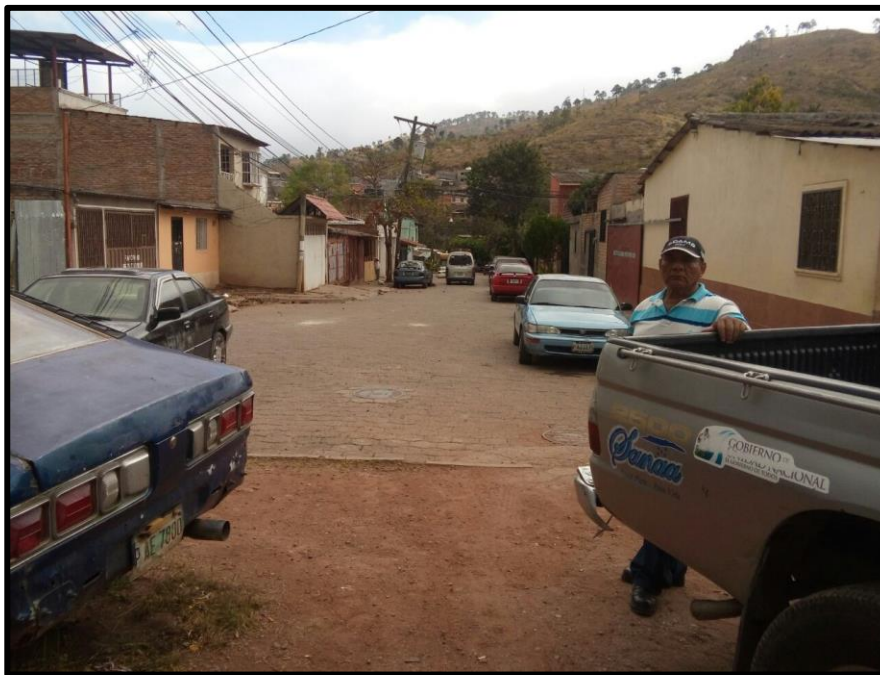
PANORAMA EN DONDE SE EJECUTARÁ LA OBRA
