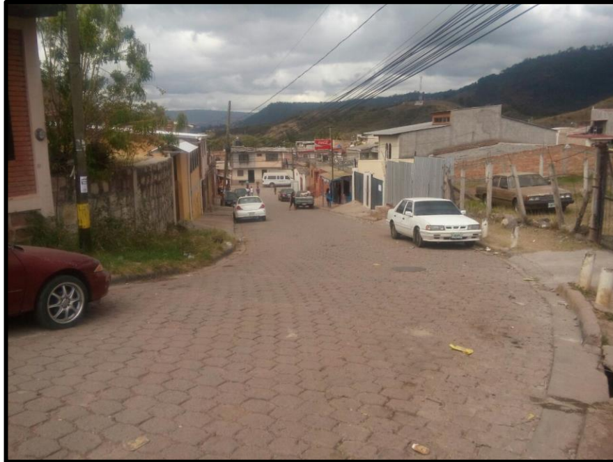
INICIO DE PROYECTO EN QUE SE INSTALARÁ LA TUBERÍA PARA AGUA POTABLE
