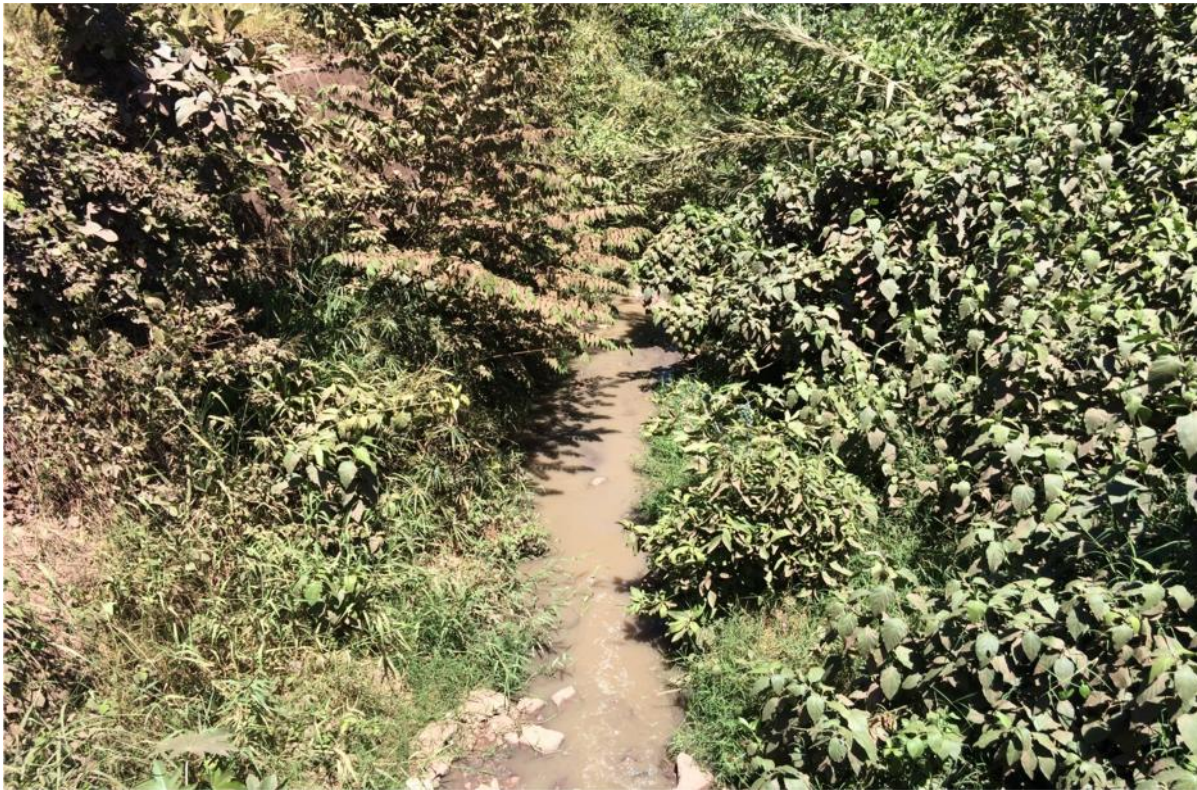
VISTA DEL TRAMO OBSTRUIDO POR MALEZA
