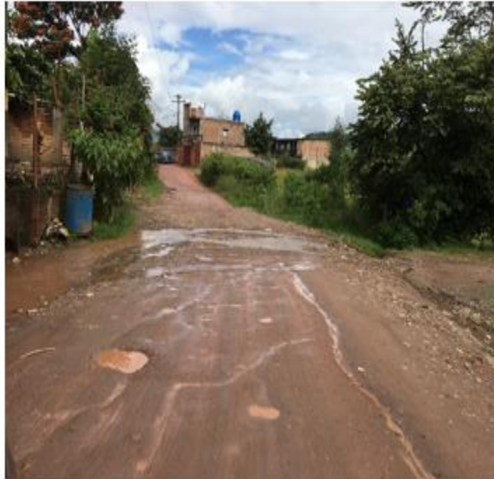
CONDICIONES DE LA ZONA DONDE INICIA LA PAVIMENTACIÓN
