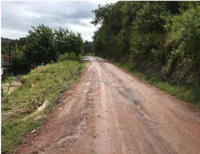
CONDICIONES ACTUALES DEL SITIO DONDE FINALIZA EL PROYECTO
