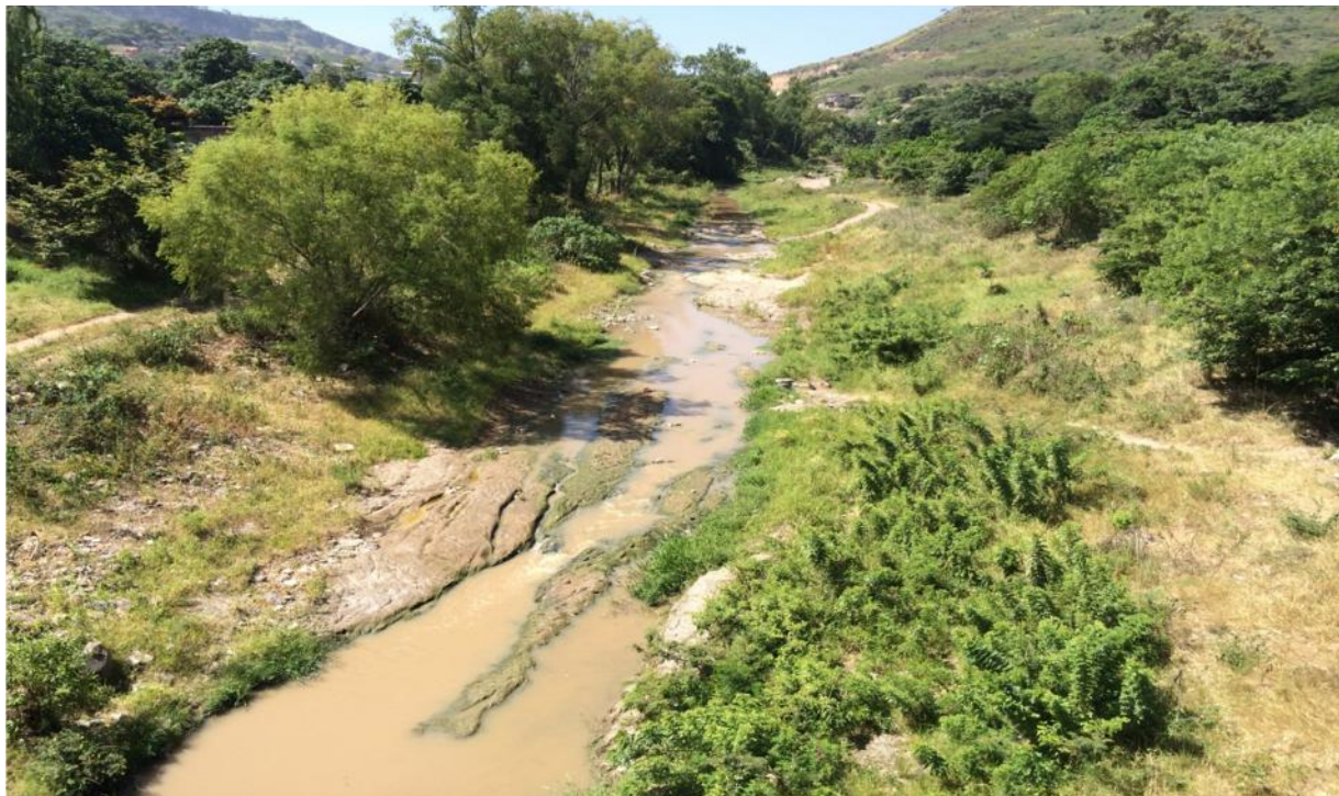
VISTA DEL TRAMO, LOCALIZADO EN COL. RIO GRANDE SUR
