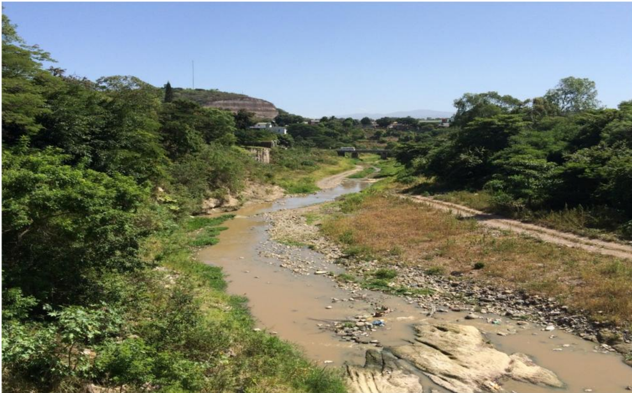
VISTA DEL TRAMO A CANALIZAR, COL. LOARQUE, VISTA AGUAS ABAJO
