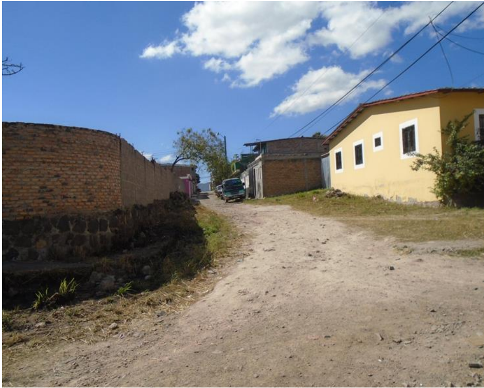
Vista de la calle a pavimentar con concreto hidráulico
