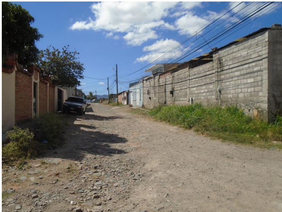
Final de la calle a pavimentar con concreto hidráulico
