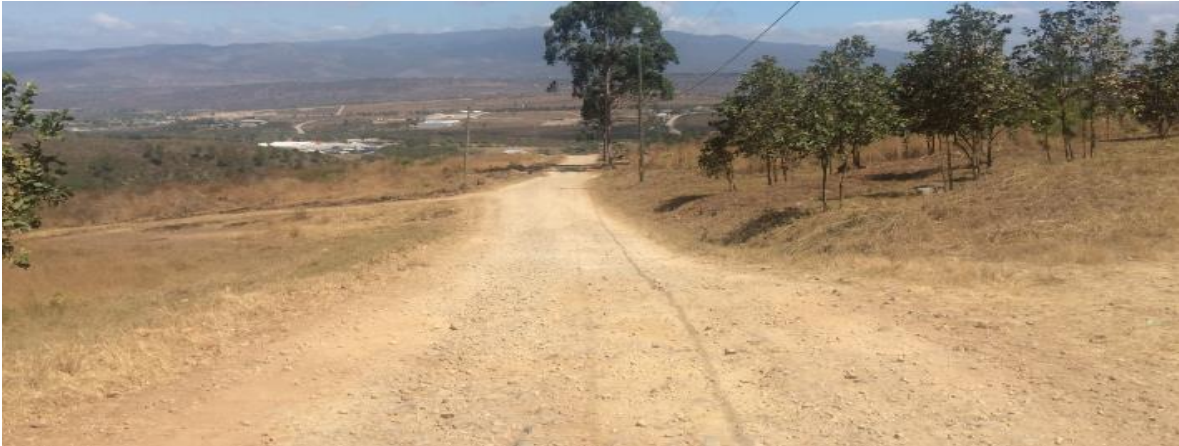
Foto 1. Condición presente en inicio de calle para realizar el balastado.
