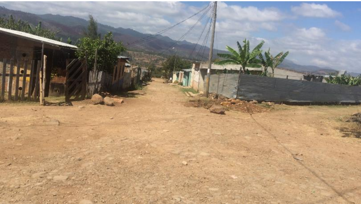
Foto 4. Tramo que presenta un mal estado de calle por lo que es necesario realizar el balastado.
