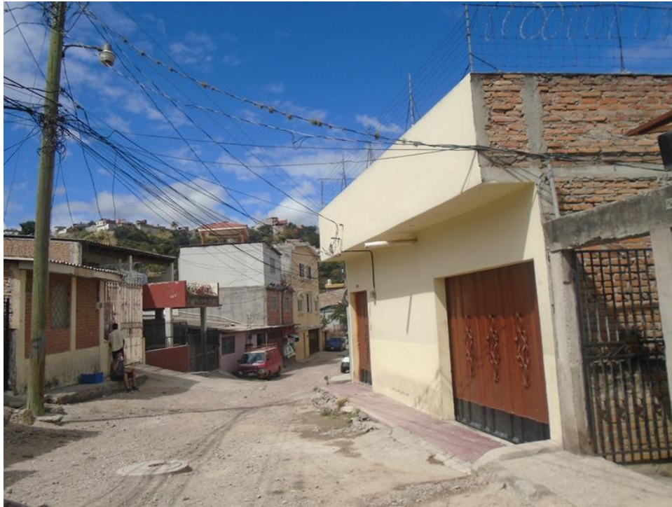
SE OBSERVA EL MAL ESTADO EN QUE SE ENCUENTRA LA CALLE
