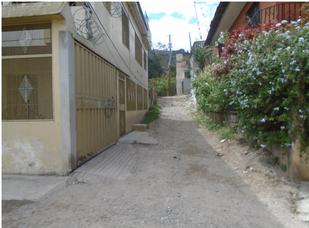
INICIO TRAMO III
