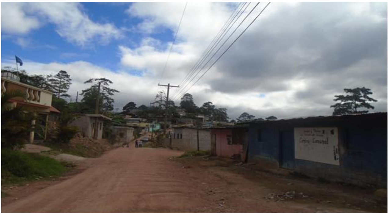
VISTA ACTUAL DE CALLES A REPARAR
