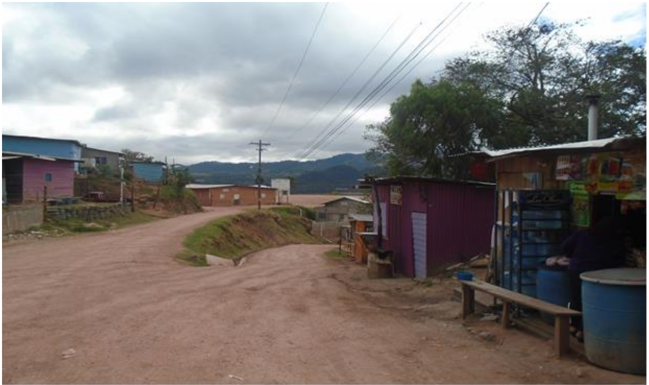
VISTA DE CALLES A REPARAR
