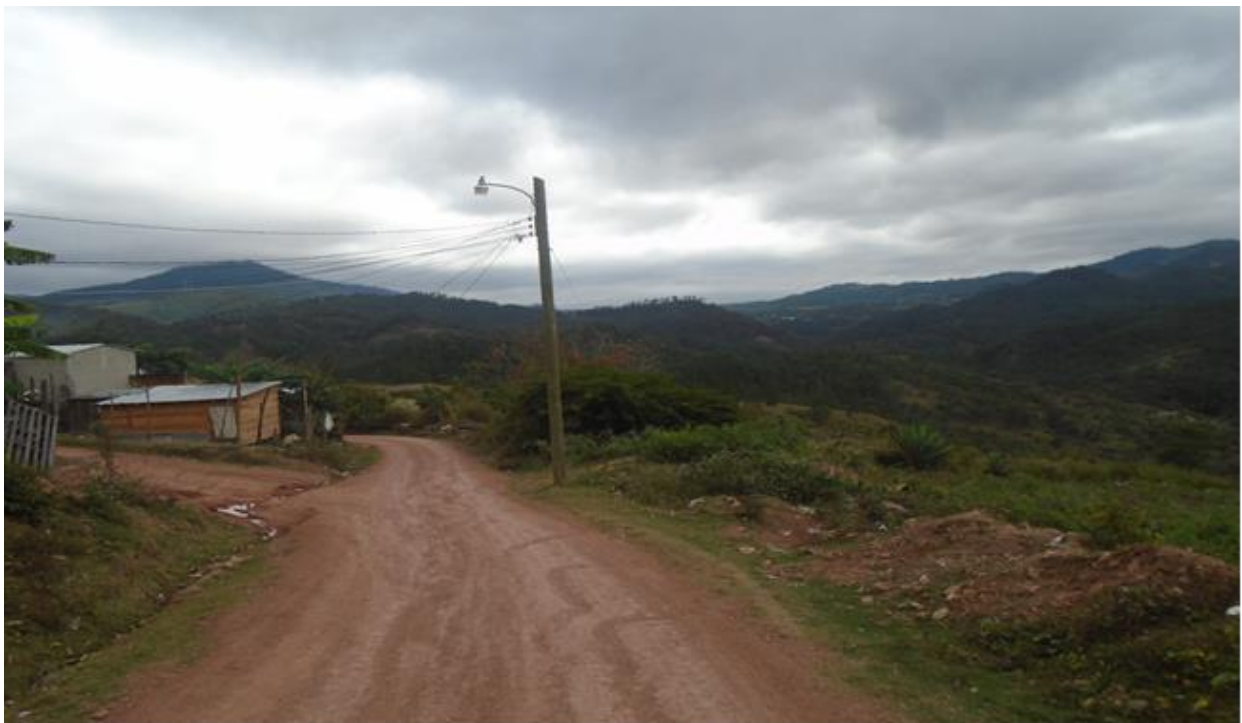
VISTA DE CALLE QUE REQUIERE BALASTADO
