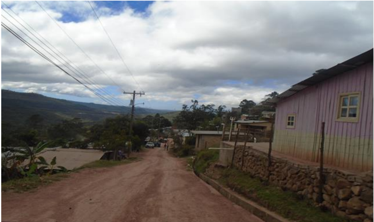
VISTA PANORAMICA DE CALLES A REPARAR
