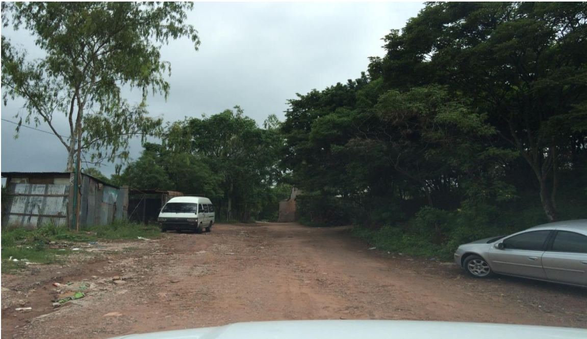
Fin de la calle a pavimentar
