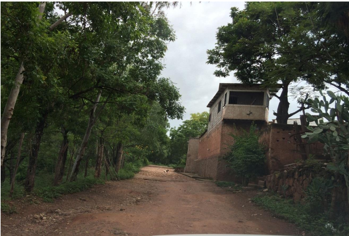
Fin de calle empedrada a pavimentar
