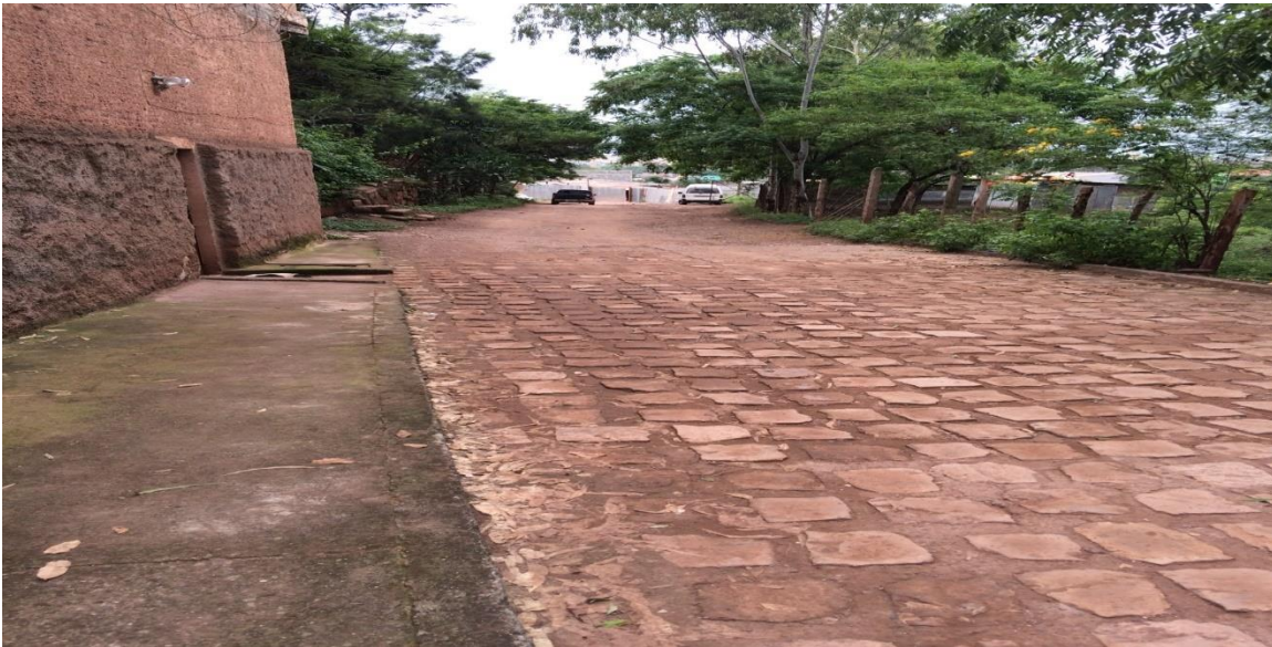
Vista de la seccion de la calle empedrada
