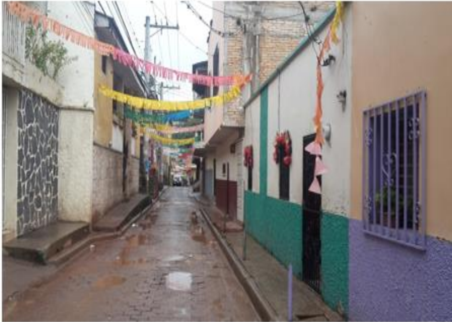
Panorama de calle a pavimentar con concreto hidráulico
