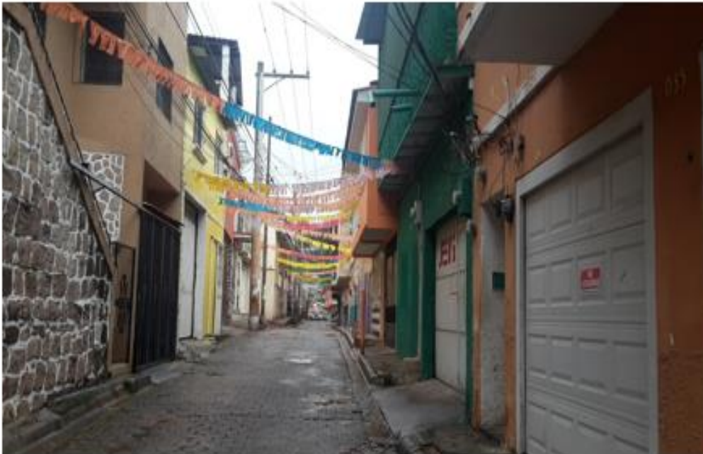
Vista de calle donde se desmontará el adoquín
