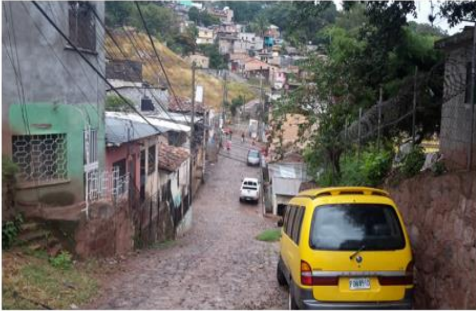
Panorama donde se hará la pavimentación
