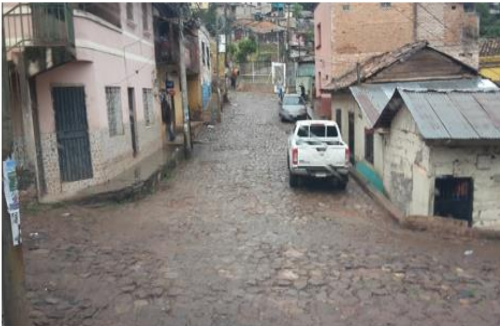
Calle a pavimentar con White Topping
