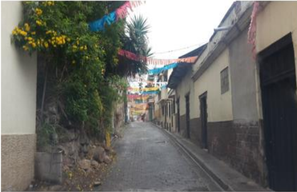
Inicio de calle a pavimentar con concreto hidráulico
