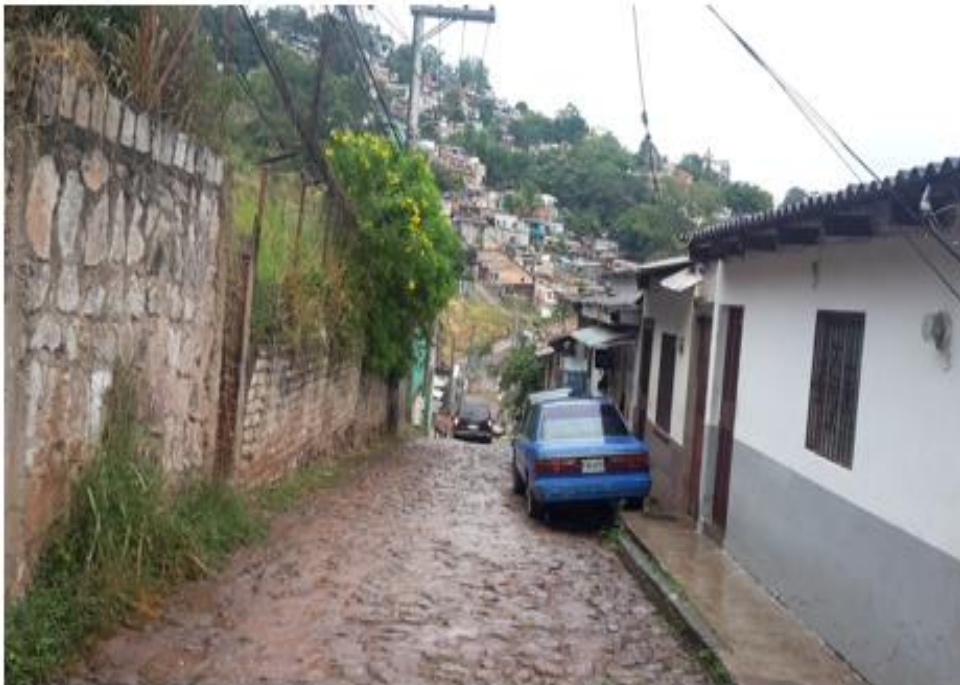
Calle a pavimentar con White Topping
