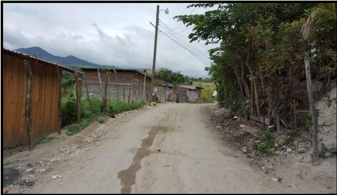
Vista de las Calles donde se construirán las Cunetas de Mampostería
