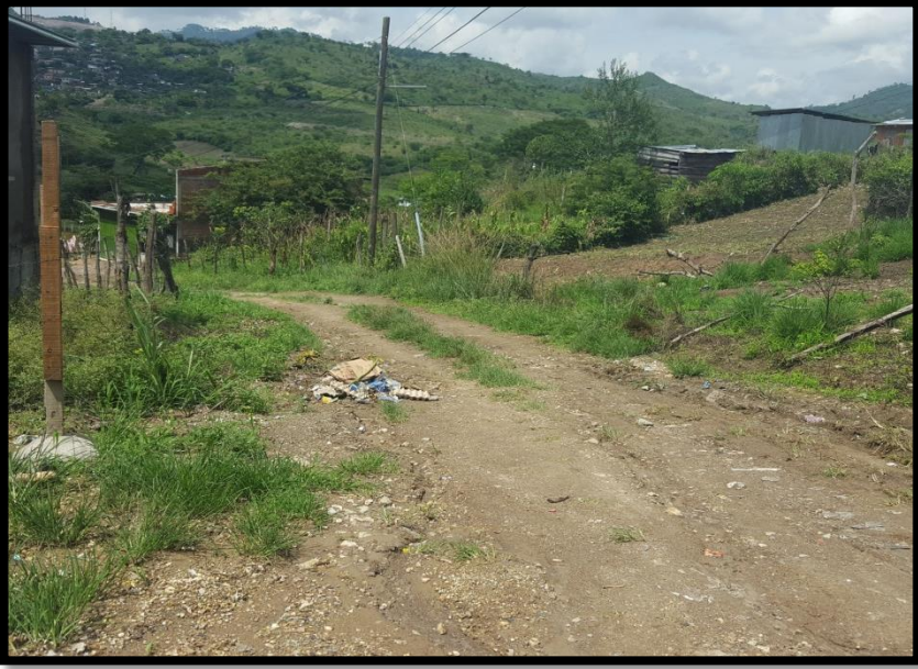
Vista de parte de los Tramos donde se construirán Cunetas de Mampostería
