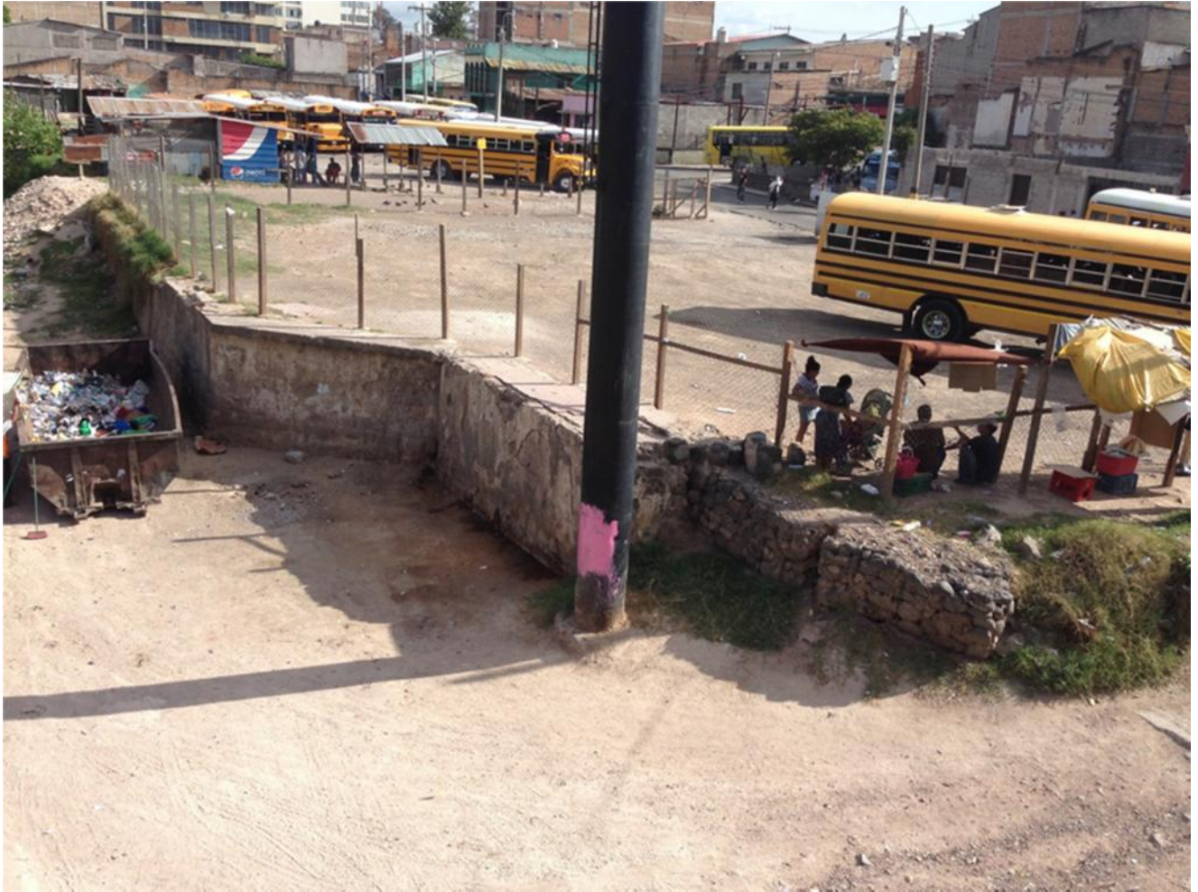
Foto No. 5. Foto tomada desde el Puente Peatonal, al fondo se observa la intersección entre la 3ra. Calle – 1ra. Avenida, desde ese punto el colector se prolongara 75 metros hasta llegar cerca del puente peatonal donde se construirá el cabezal de salida
