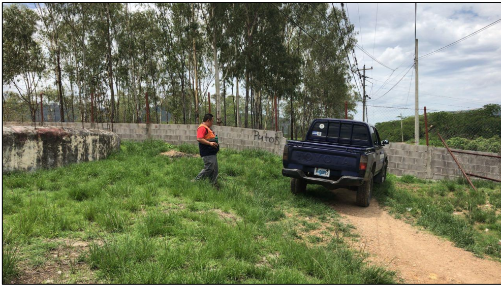
Foto No. 10 Área a utilizar para construcción de tanque colonia Villa Madrid
