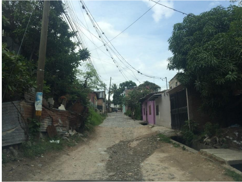
INICIO DE PAVIMENTACION DE CALLE
