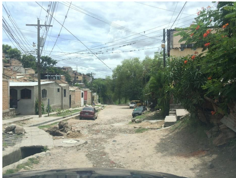
FINAL DE CALLE A PAVIMENTAR
