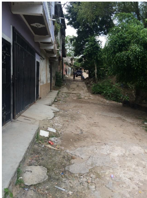
VISTA PANORAMICA DE CALLE A PAVIMENTAR
